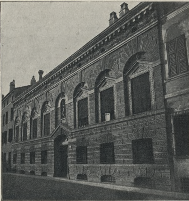
Abb. 77. Haus des Giulio Romano.
