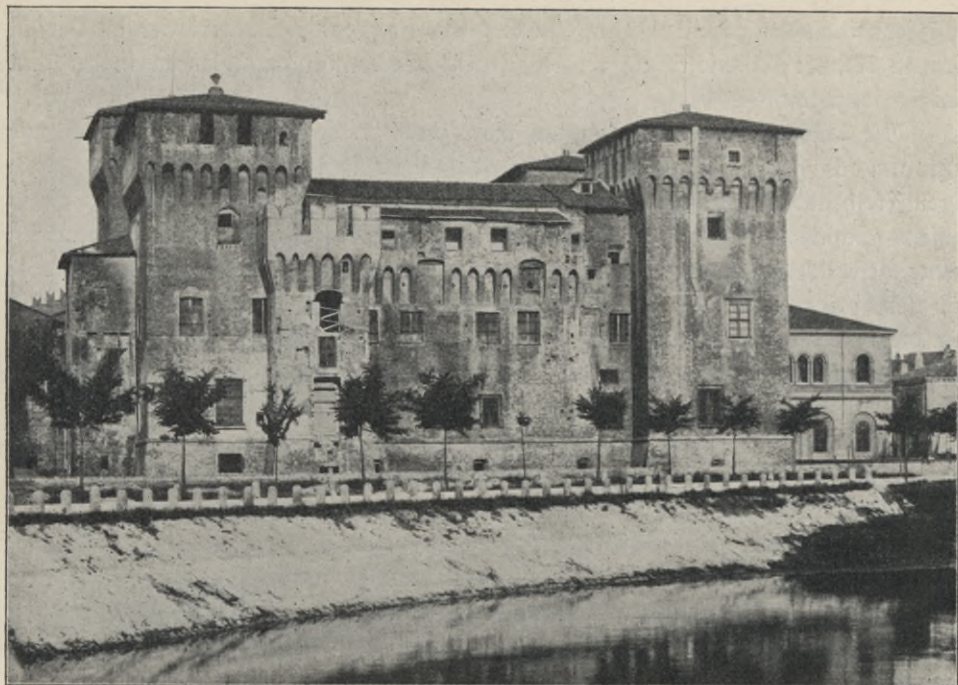
Abb. 10. Das Castello di Corte von der S. Giorgio-Brücke aus gesehen.
