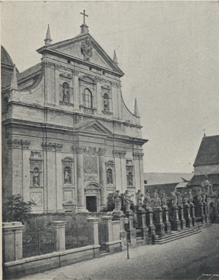
Abb. 72. Fassade der St. Peterskirche.
