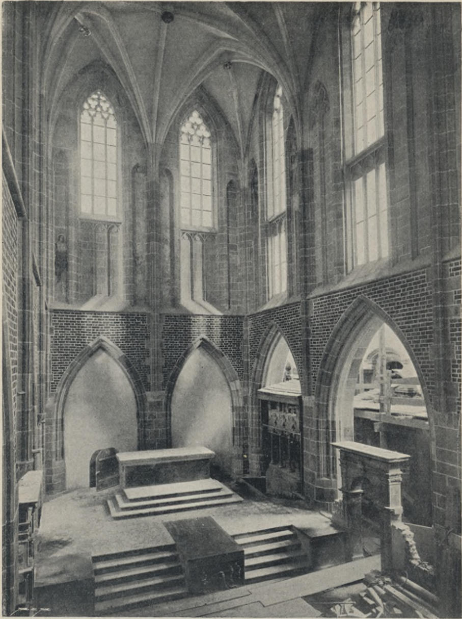
Abb. 23. Das Innere des Chores während der Restaurierungsarbeiten.
