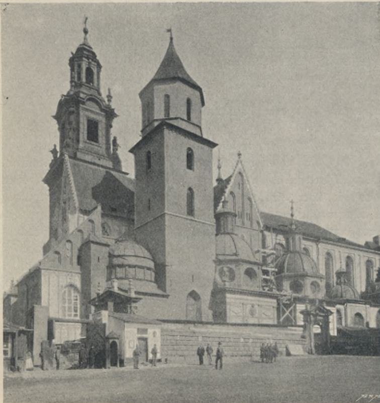
Abb. 28. Ansicht des Domes von Süden.
