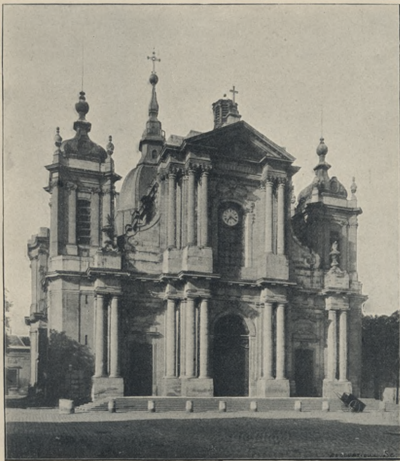
Abb. 118. Fassade der St. Ludwigs-Kirche.
