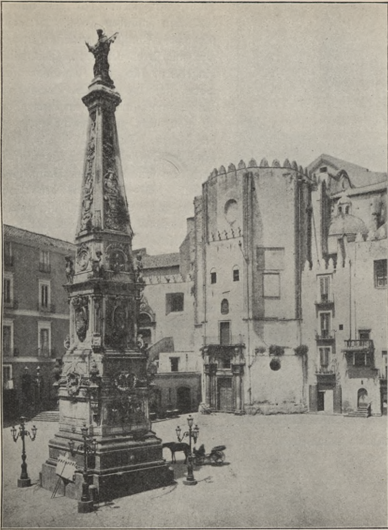
Abb. 40. Dominißsäule; im Hintergrunde der Kor von S. Dominiß.
