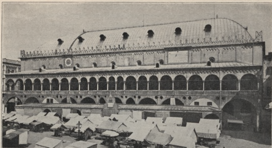
Abb. 11. Der Salone, Außenansicht.
