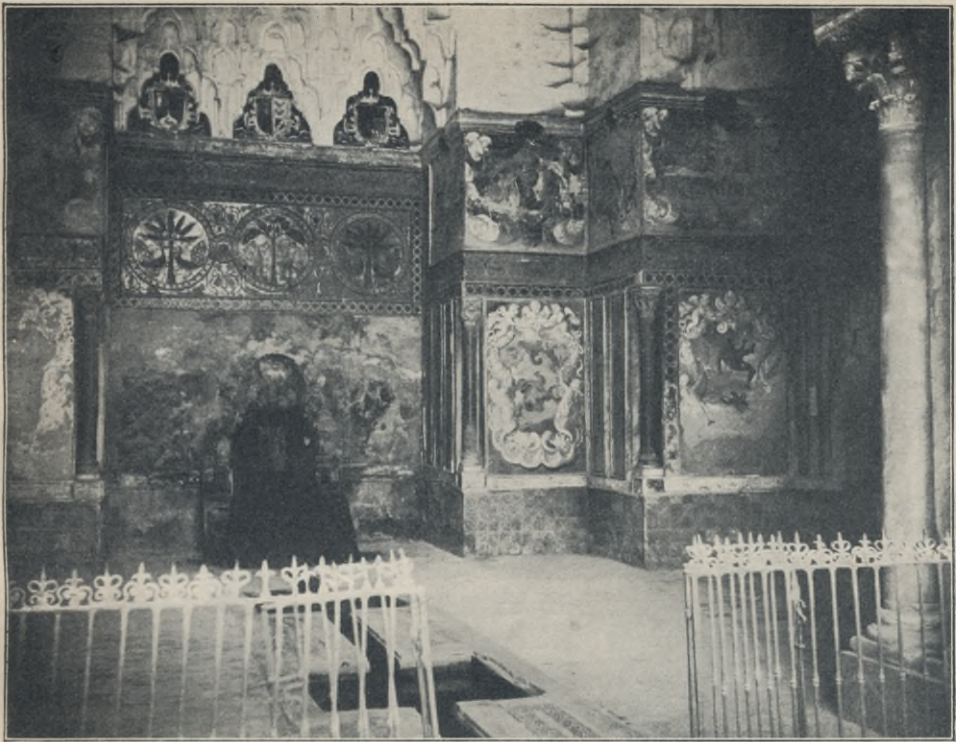
Abb. 18. Quellenraum der Zisa.
