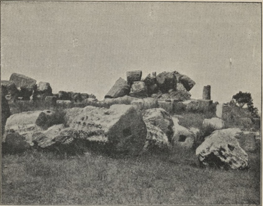
Abb. 66. Sog. Herakleiontempel zu Girgenti. Ansicht von Osten.
