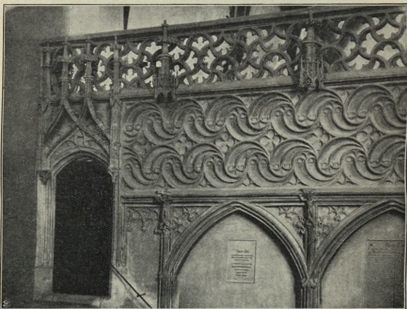
Abb. 21. Brüstung im Westchor des Domes.
