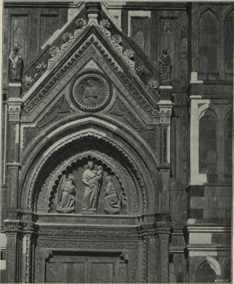
Abb. 44. Dom. Erstes Portal der Südseite.
