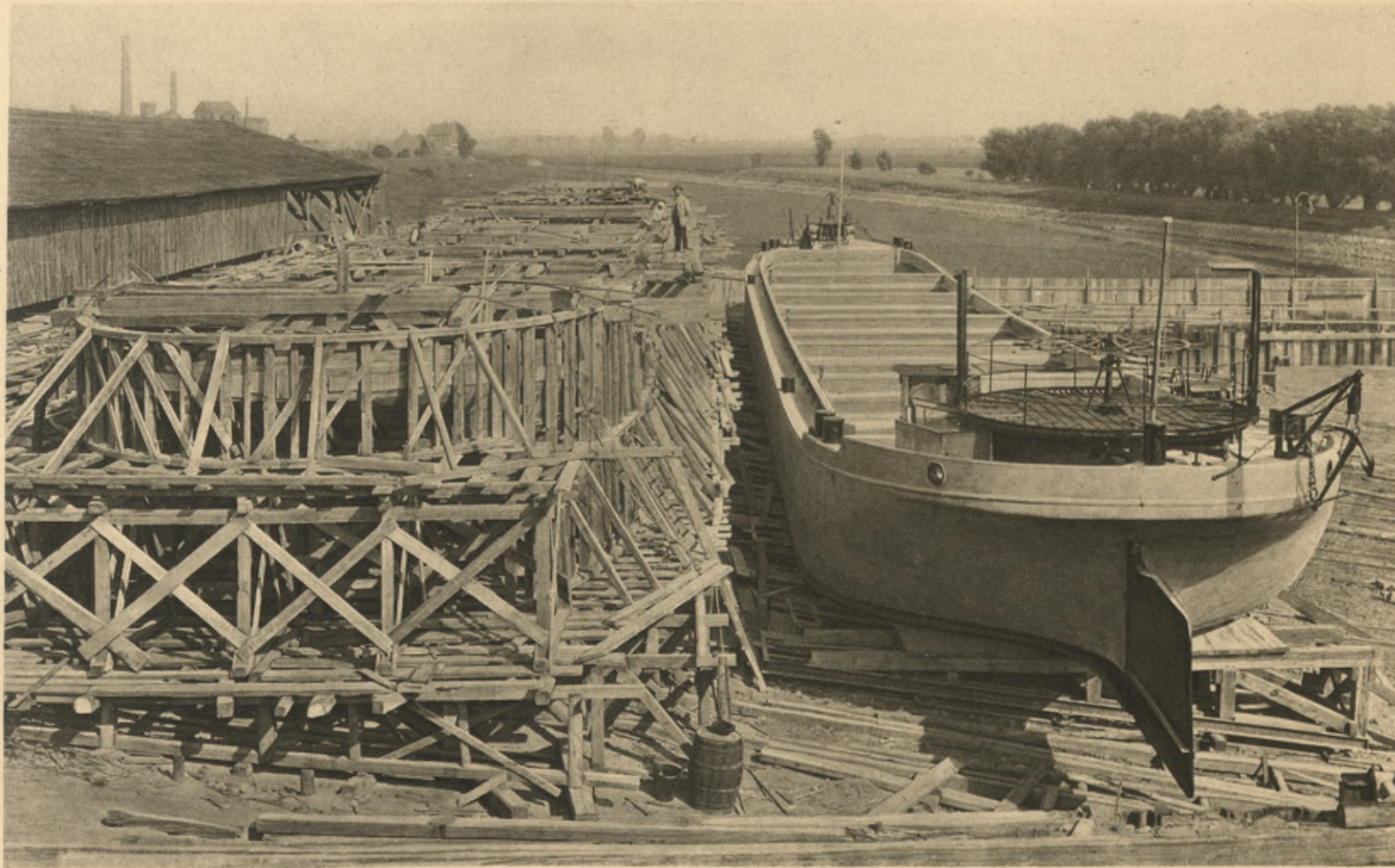
Eisenbetonschiffbau auf der Werft in Neuss-Düsseldorf
