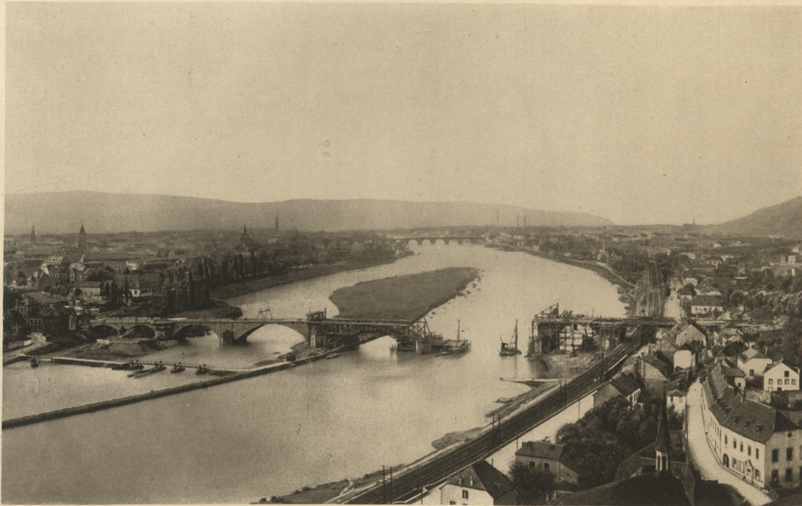
Moselbrücke in Trier
