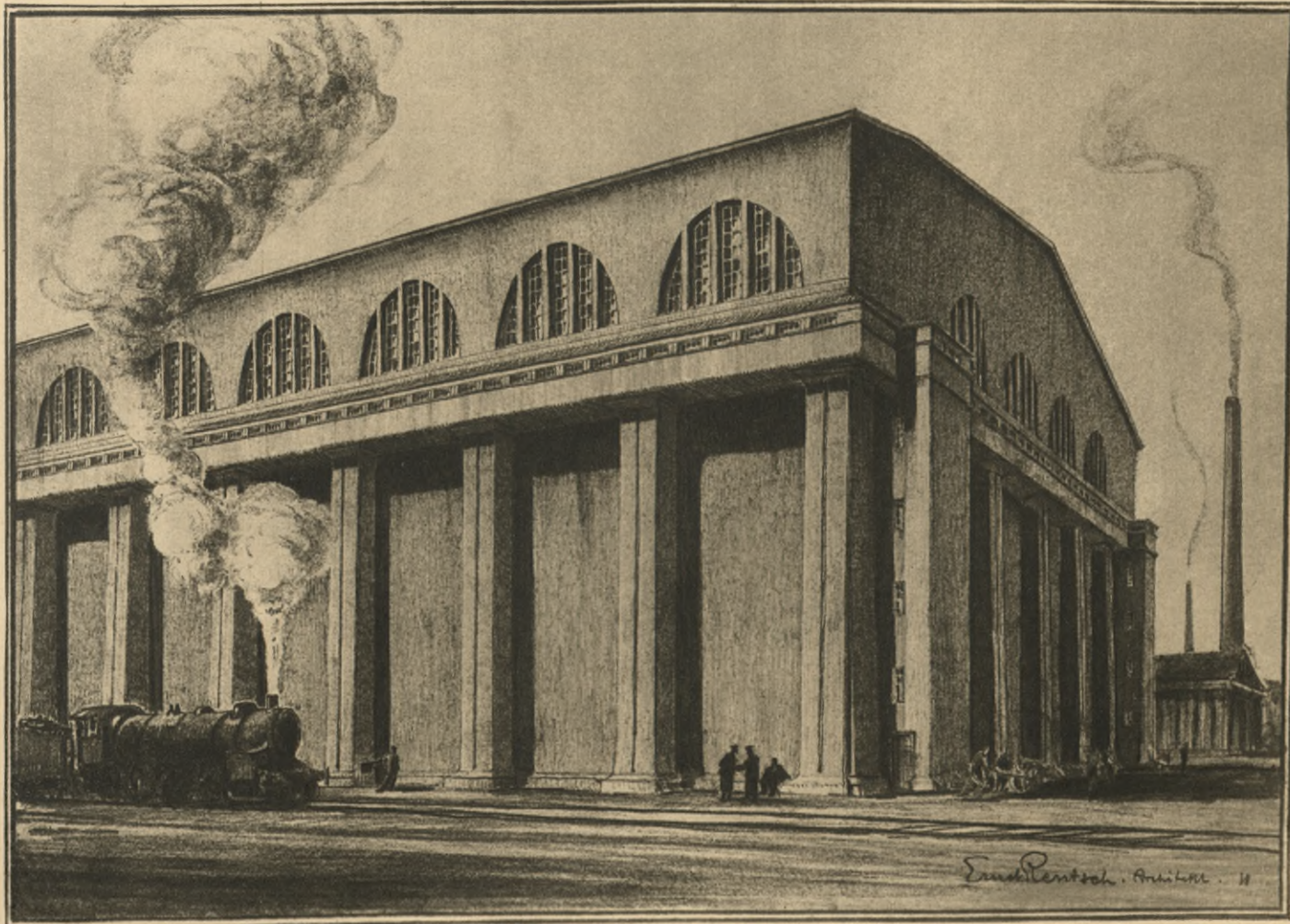
Bunker für 315 000 cbm Ammoniumsulfat in Merseburg
