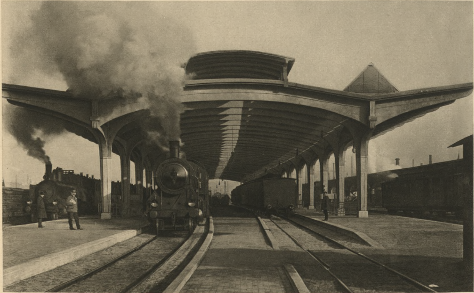
Bahnsteighallen im Hauptbahnhof Nürnberg
