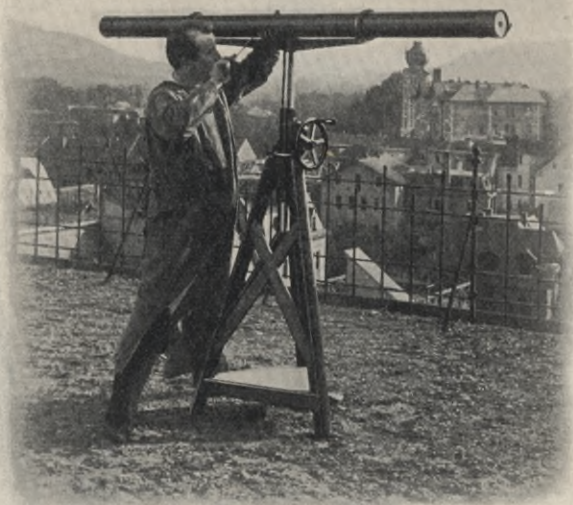
Fig. 47. Justieren eines Aussichtsfernrohres.
