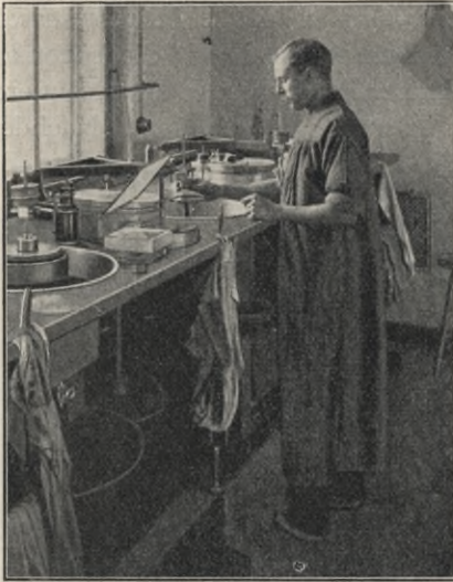
Fig. 67. Linsenpolieren.
