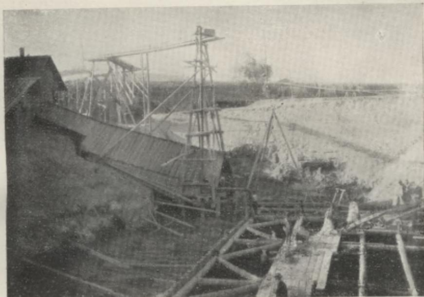
Schleuse an der Begamündung. Erdaushub zwischen den Spundwänden.
