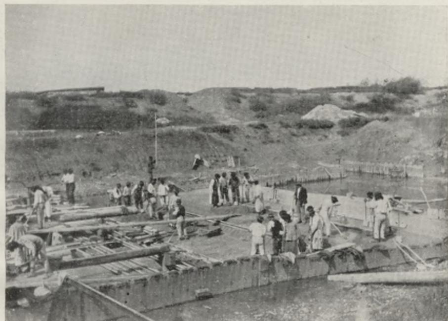
Écskaer Schleusse. Anbringen der Eisenschienen-Einlagen.
