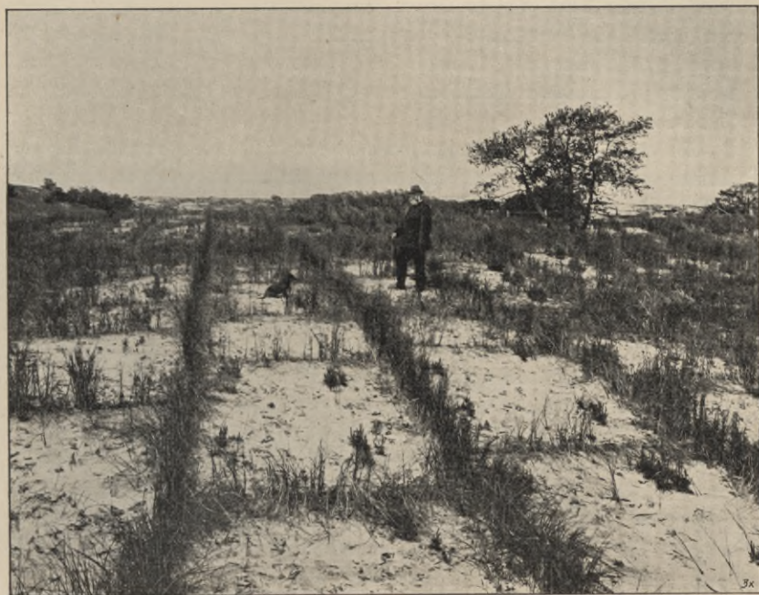
Abb. 328. Kiefernpflanzen in Sandgrasbesteck mit Deckreisig bei Neutief auf der frischen Nehrung. (Aufnahme von P. Gerhardt 1898.)
