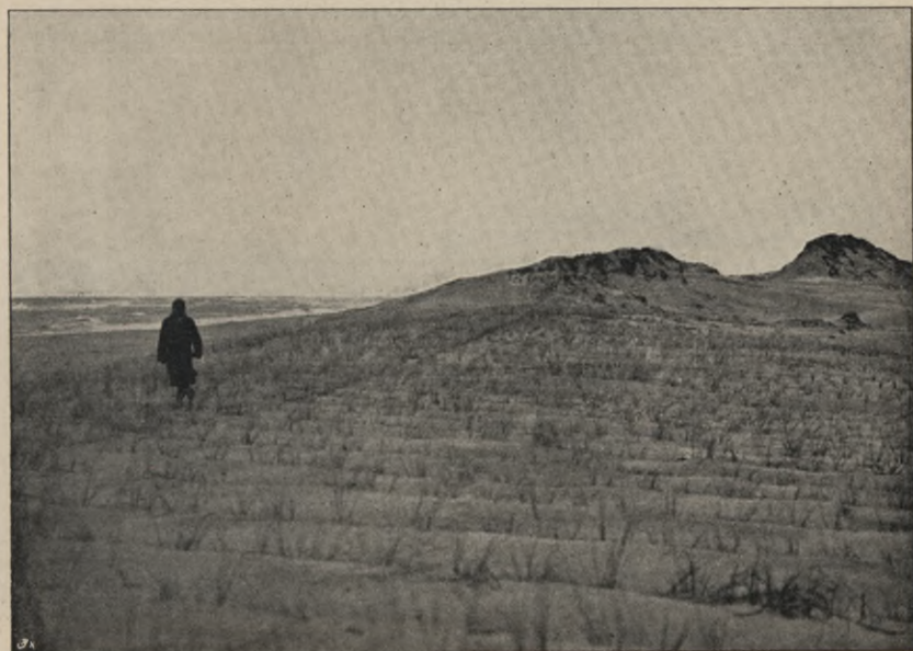
Abb. 278. Anlage einer neuen Vordüne zwischen Sarkau und Rossitten. (Aufnahme des Verfassers 1899).
