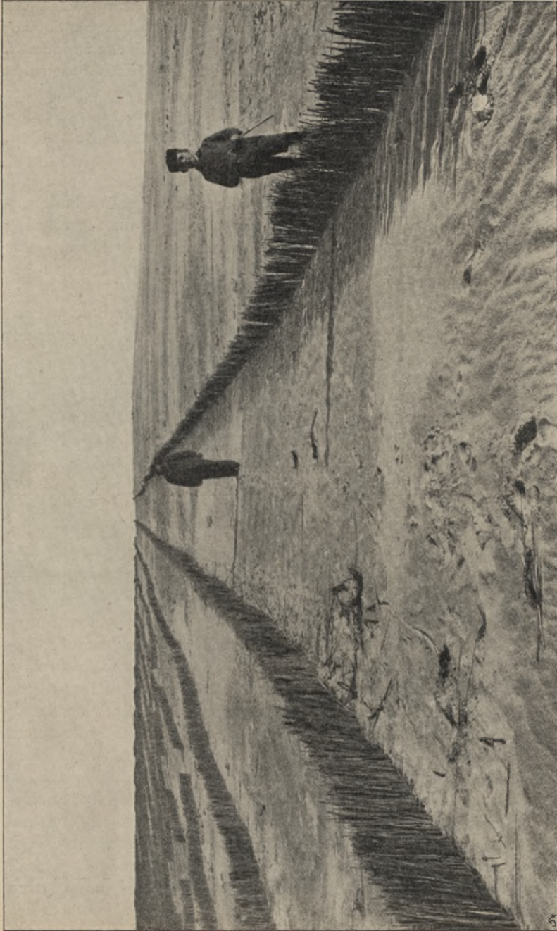
Abb. 301. Schutzstreifen aus Rohr zur Festlegung der Wanderdünen zwischen Süderspitze und Schwarzort auf der kurischen Nehrung. (Aufnahme des Verfassers 1898.)
