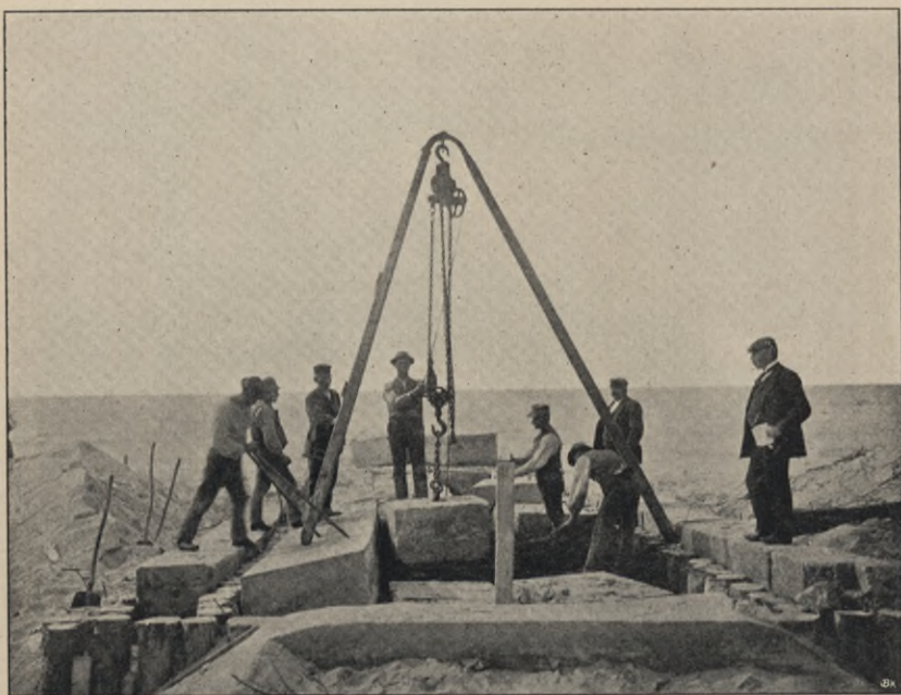
Abb. 377. Unterfüllen der Steindecke bei den Buhnen auf Sylt. (Aufnahme des Verfassers 1898.)
