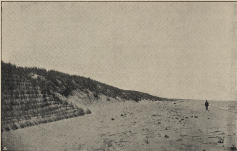
Abb. 290. Ausbesserung geringer Beschädigungen der Vordüne durch Sandgras. (Aufnahme des Verfassers.)
