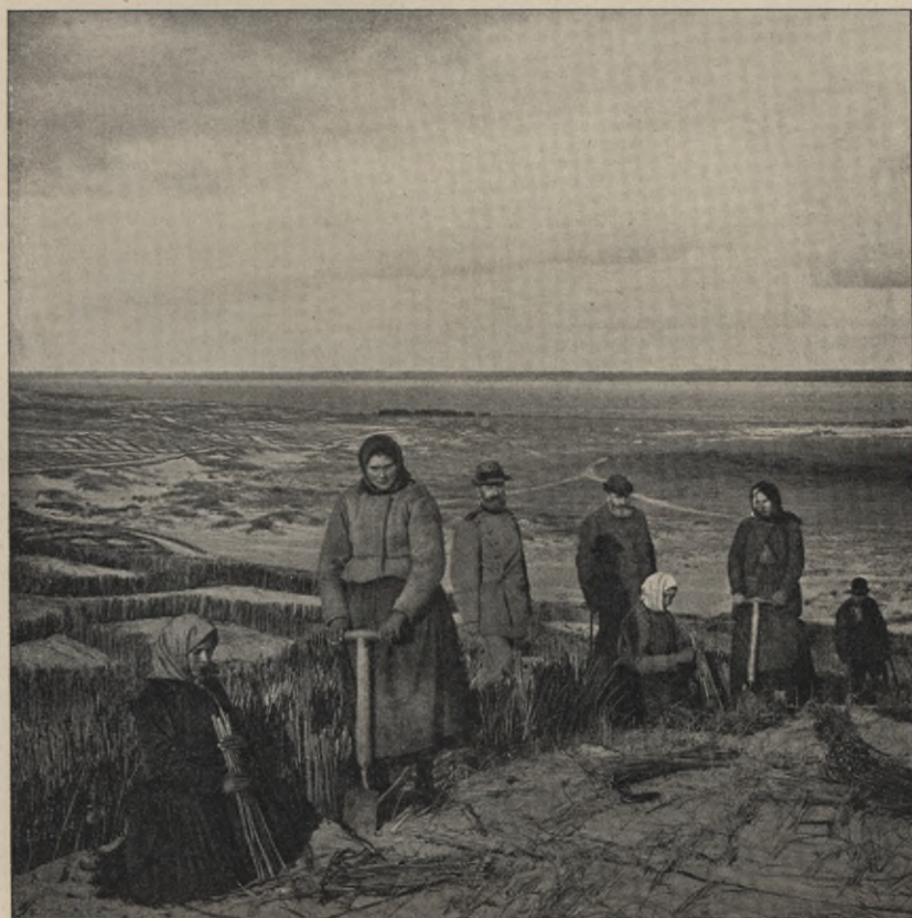
Abb. 219. Setzen des Rohrbestecks auf den Wanderdünen zwischen Süderspitze und Schwarzort (Aufn. d. Verf. 1898).
