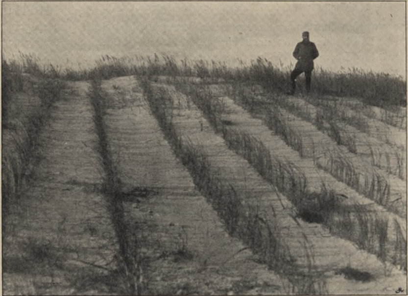
Abb. 283. Sandgraspflanzung auf der landseitigen Böschung der Vordüne. (Aufnahme des Verfassers 1898).
