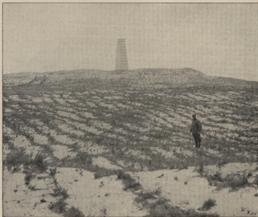
Abb. 230. Heidekraut-Besteck auf den Dünen bei Stilobake in Pommern. (Aufnahme des Verfassers 1898.)
