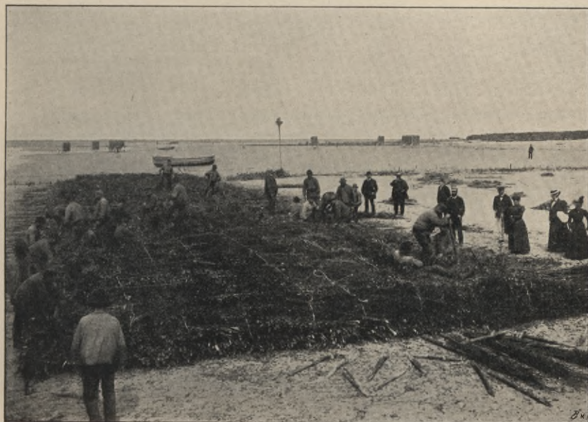
Abb. 391. Bau eines Sinkstückes vor der Düne bei Helgoland. (Nach einer Aufnahme des Hofphotographen F. Schensky in Helgoland.)
