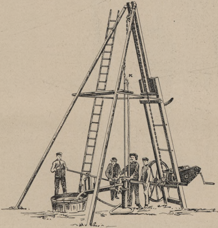
Abbildung 32. Spülbohrung in Betrieb.
