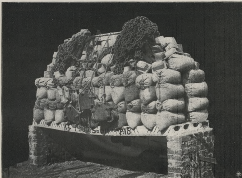
Fig. 42. Belastungsprobe in Luzern.
