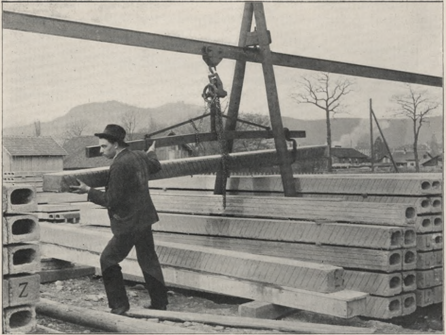
Fig. 38. Transport am Hängegeleise.
