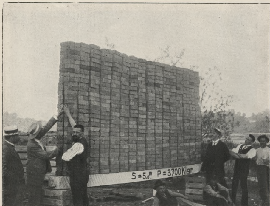
Fig. 43. Belastungsprobe in Luzern.
