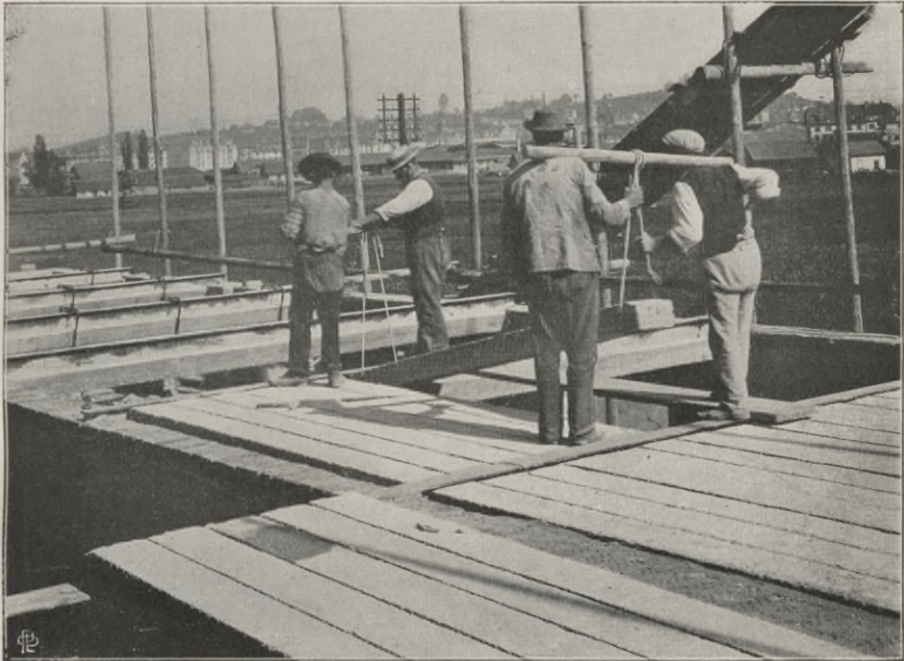
Fig. 32. Verlegen der Siegwartbalken zwischen einbetonierte I-Unterzüge.
