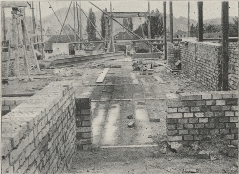
Fig. 28. Pestalozzi-Schulhaus in Luzern.
