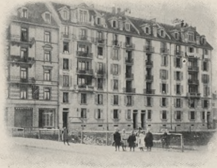
Wohnhäuser Mandrino, Luzern (sämtliche Decken in Siegwartbalken).
