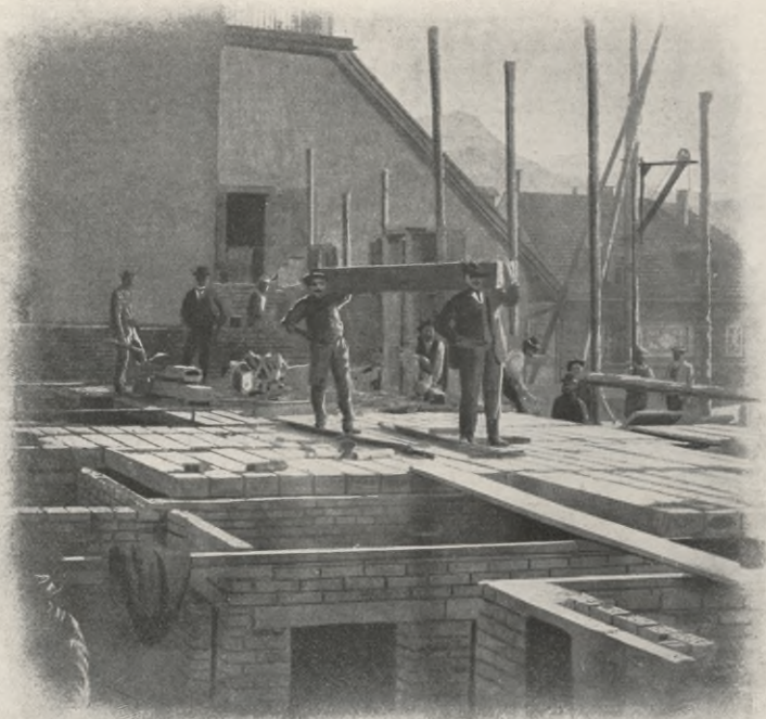
Fig. 5. Verlegen der Balken auf Mauern.
