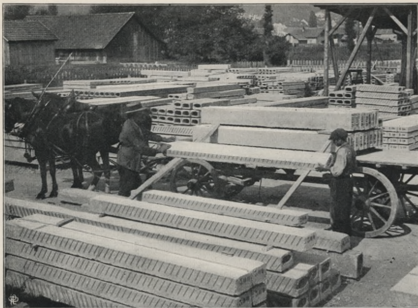
Fig. 40. Transport der Siegartbalken per Wagen.
