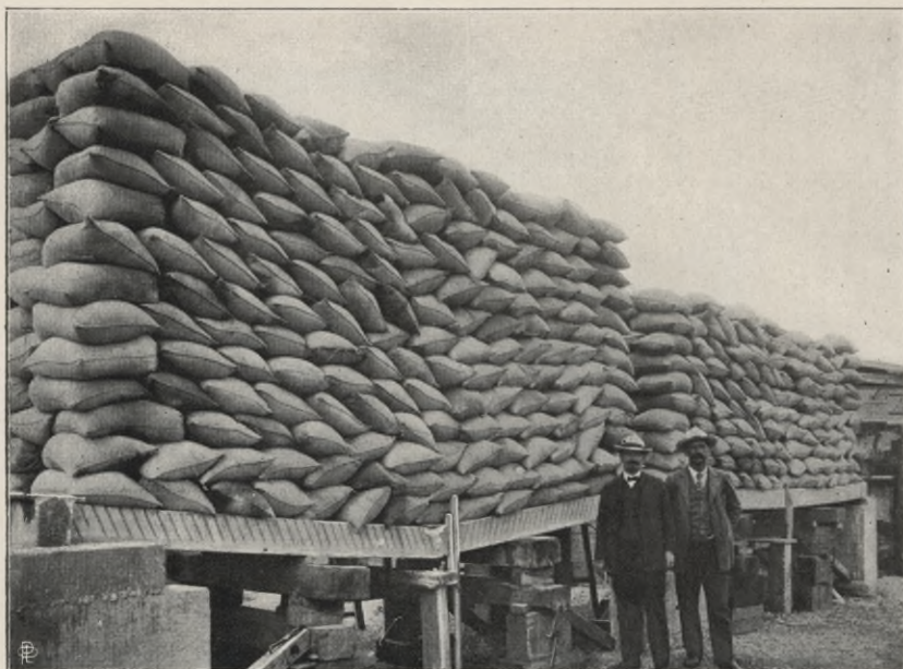
Fig. 45. Amtliche Belastungsproben in Wien vom 27. Juni 1904. Balkenlage Profil 18. Spannweite 5 m. Bruchlast 3467 kg pro m 2 .
