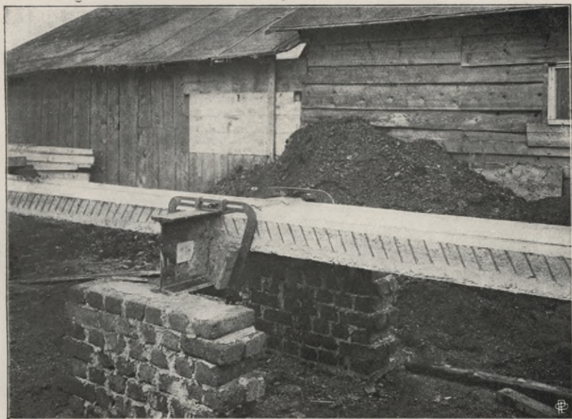
Fig. 16. Betonaufleger der Siegwartbalken an einem I-Träger.
