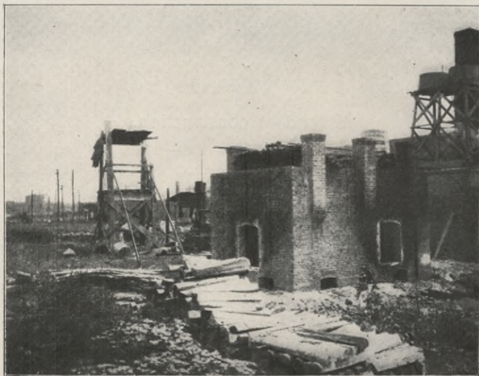
Feuerhaus in New-York nach der Probe.
