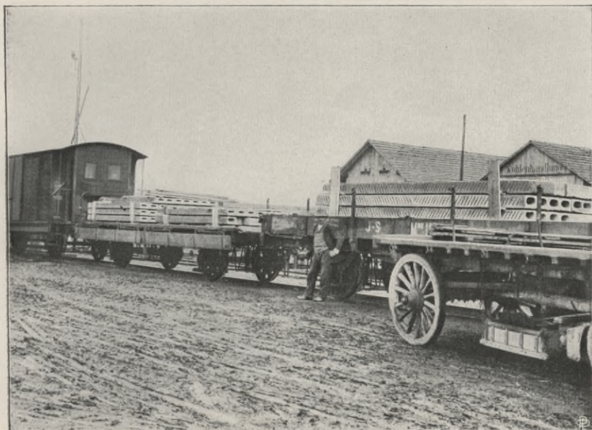
Fig. 36. Transport der Balken per Eisenbahn.
