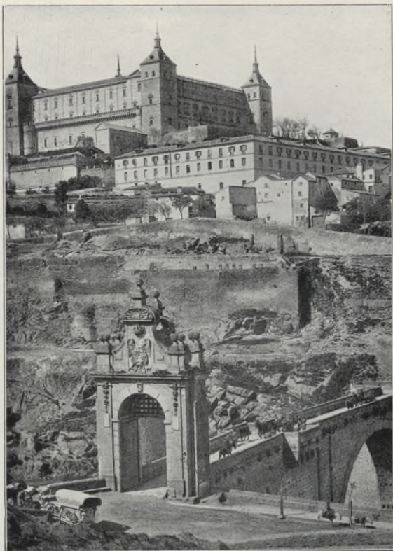
Abb. 41. Blick auf den Alcazar mit Stadtmauer und Alcantarabrücke
