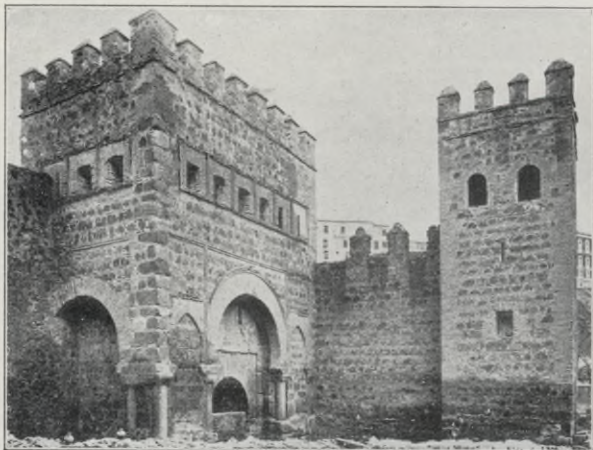
Abb. 11. Das alte Bisagratior vor der Restauration
