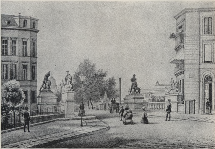
Abb. 109. Die Herkulesbrücke um 1850.
