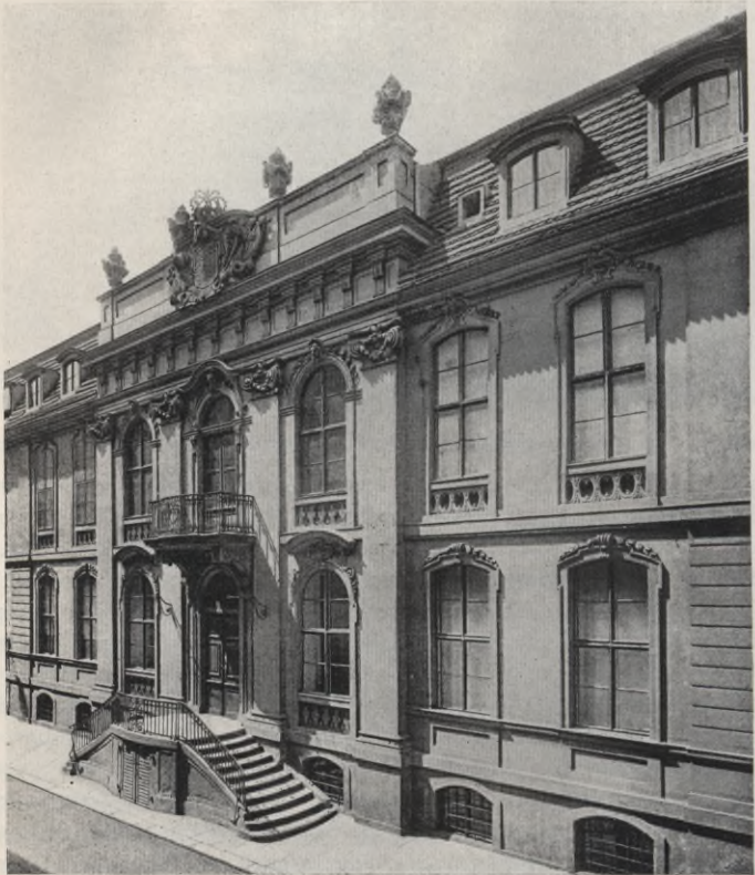
Abb. 81. Prinzessinnenpalais, Fassade in der Oberwallstraße.
