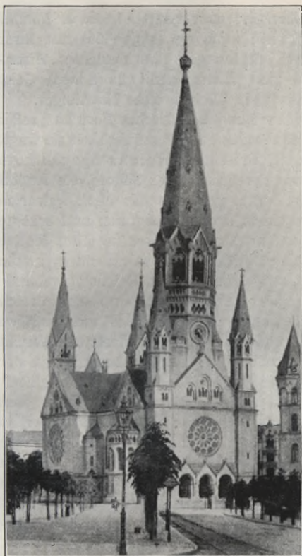
Abb. 147. Kaiser Wilhelm-Gedächtniskirche, erbaut von F. H. Schwechten, 1891—95.
