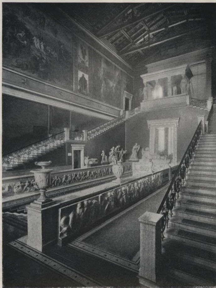
Abb. 140. Treppenhaus des Neuen Museums, erbaut von Stüler, 1843–55.
