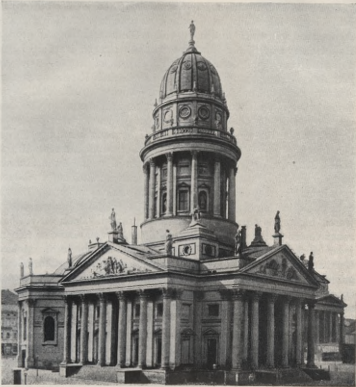
Abb. 98. Der Turmbau der Neuen Kirche auf dem Gendarmenmarkt.
