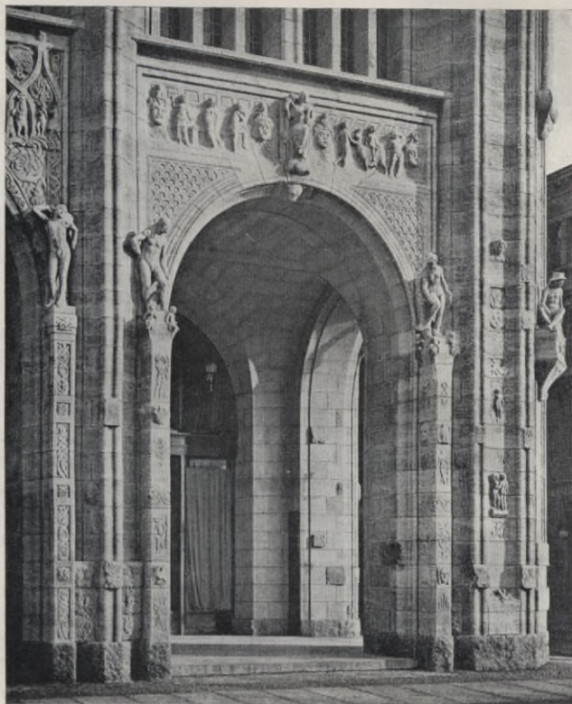
Abb. 157. Detail vom Warenhaus Wertheim (Eckbau am Leipziger Platz).
