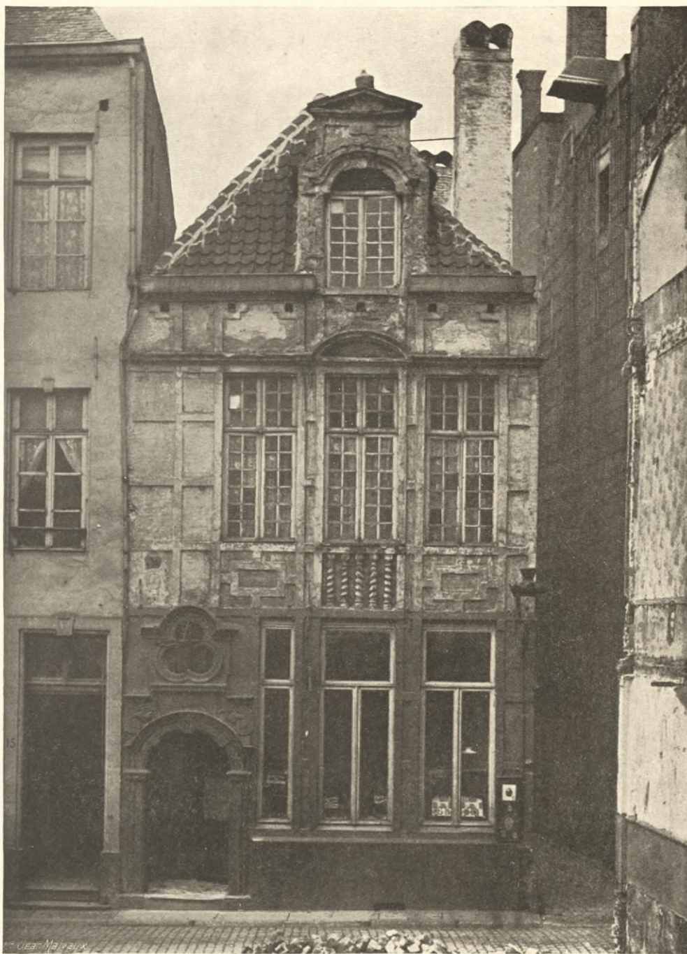
Maison à lucarne. Porte à abat-jour trilobé.
