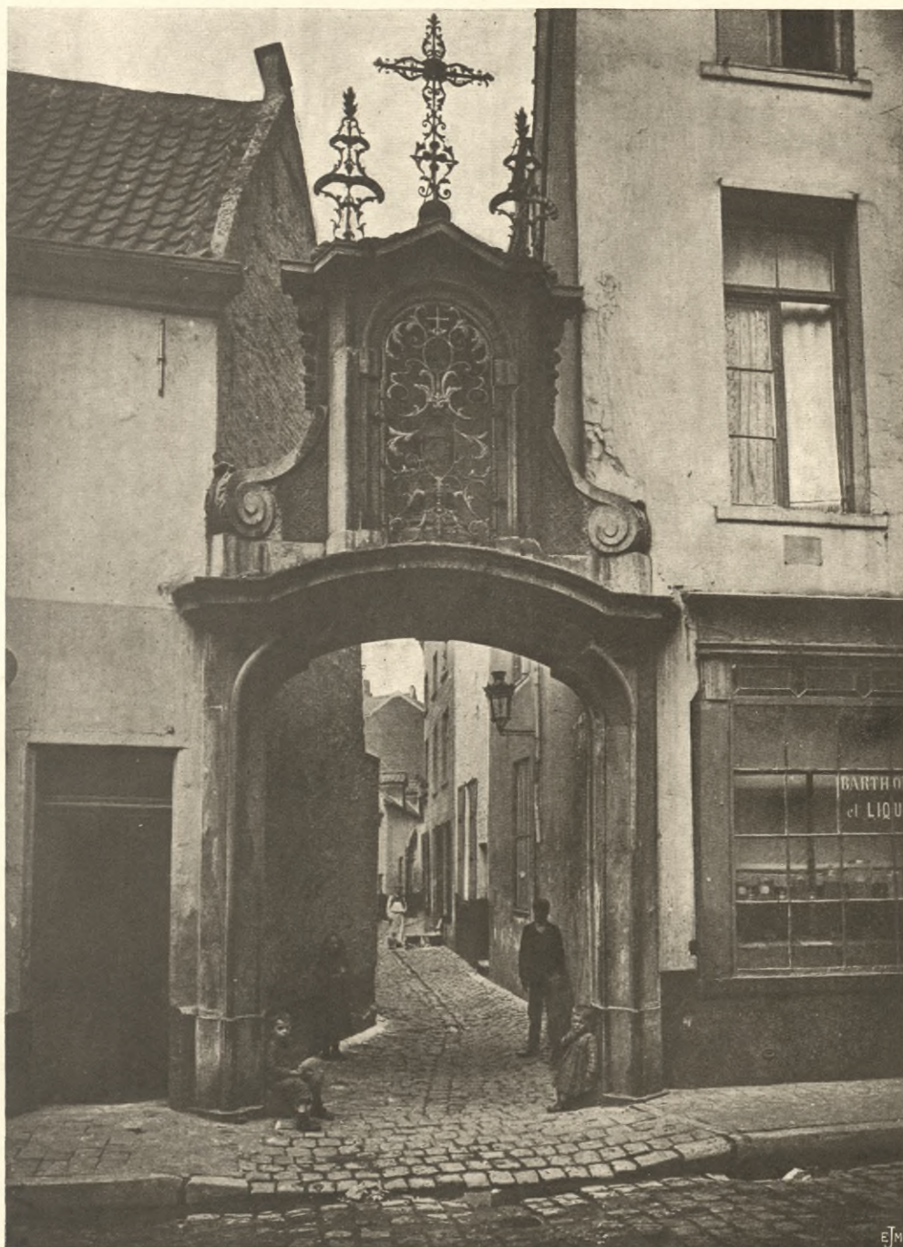
Chapelle de style Louis XIV, dédiée à saint Roch. Rue du Rempart-des-Moines (entrée de la rue de la Cigogne).
