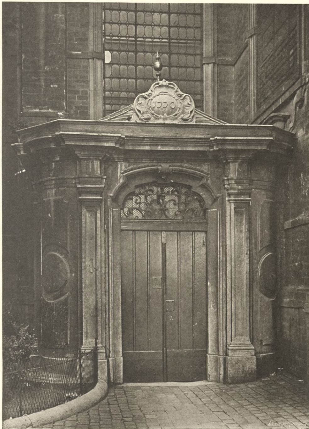
Portail latéral de l'église du Béguinage daté de 1770.
