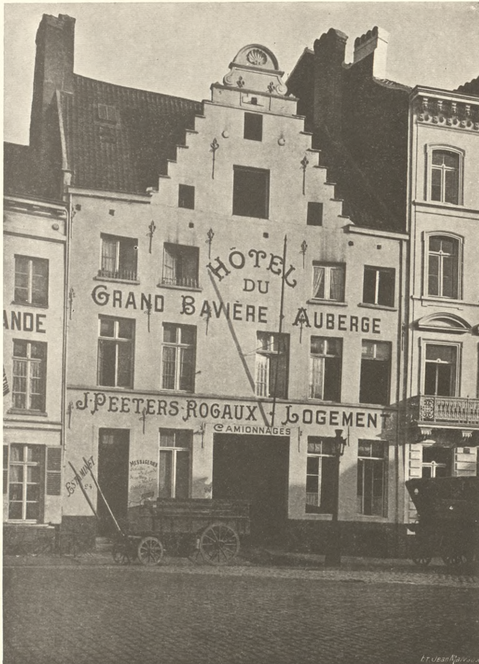
Pignon à gradins surmonté d'un fronton semi-circulaire orné d'une coquille.
