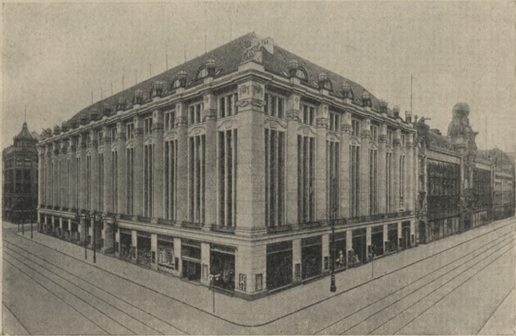
Gesamtansicht des Warenhauses Hermann Tietz in Berlin.
