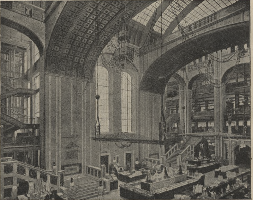
Lichthof des Warenhauses A. Wertheim in Berlin. (III. Bauperiode 24 ).
