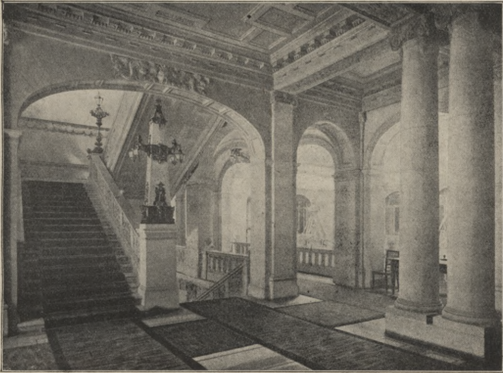
Treppe im Gebäude der Diskonto-Gesellschaft in Berlin 104 ).
