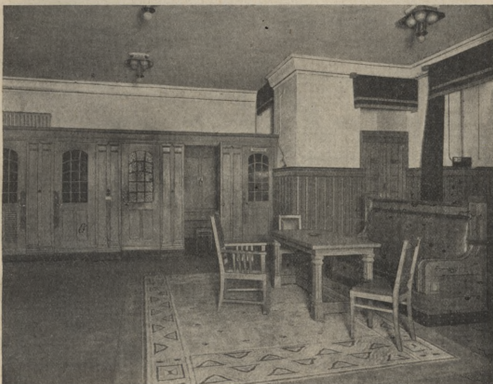
Treforraum im Keller der Dresdner Bank in Berlin 144) .
