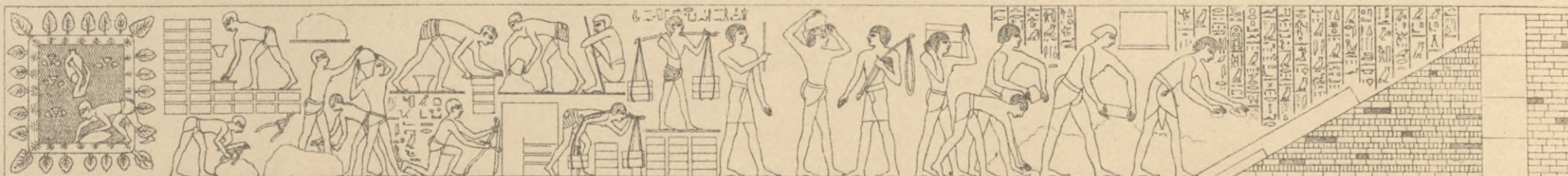
13. Bau eines Tempels durch Gefangene.
