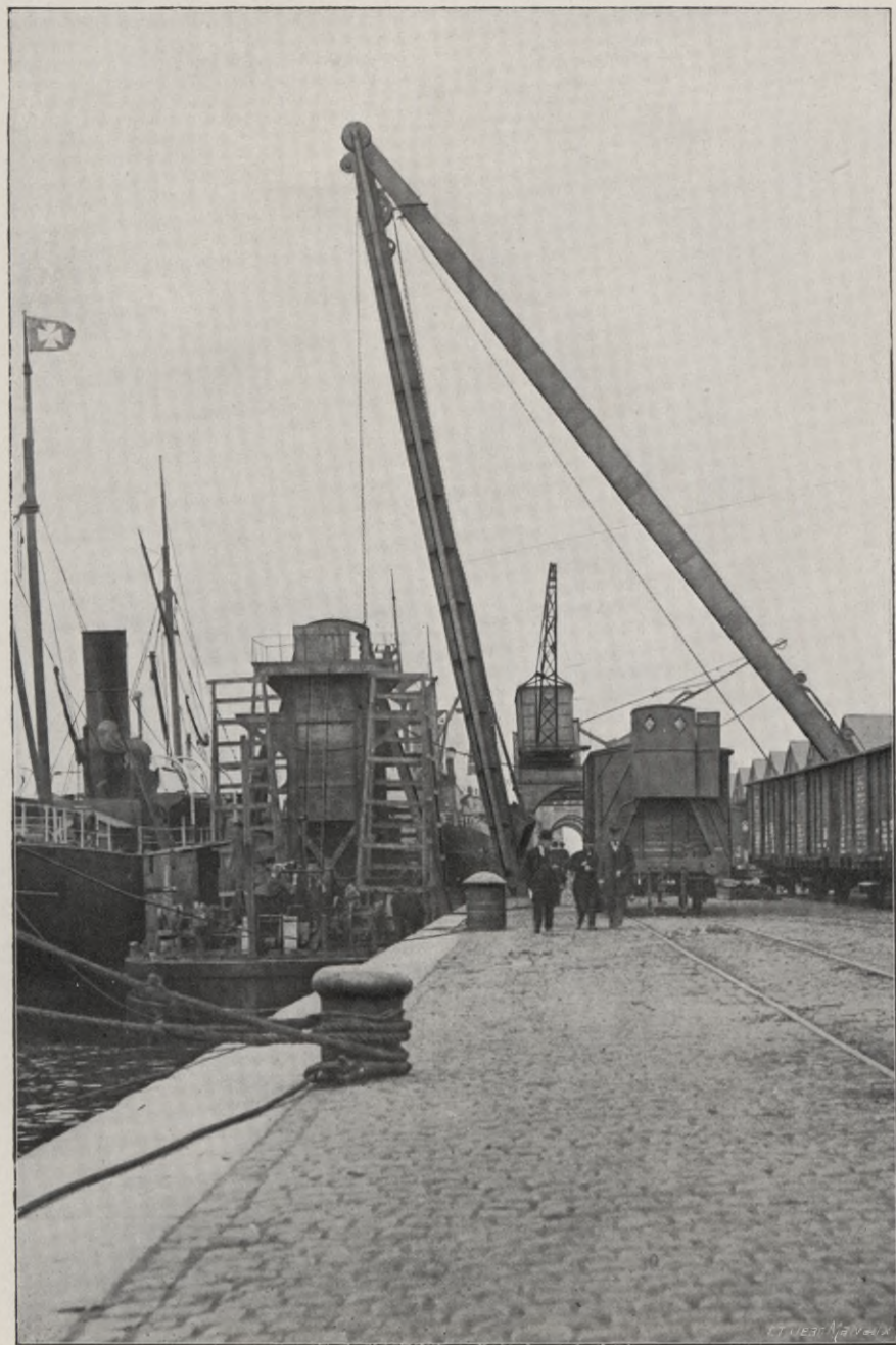
Grue de 120,000 kilogrammes (établie au port d'Anvers). (Société anonyme John Cockerill, à Seraing.)
