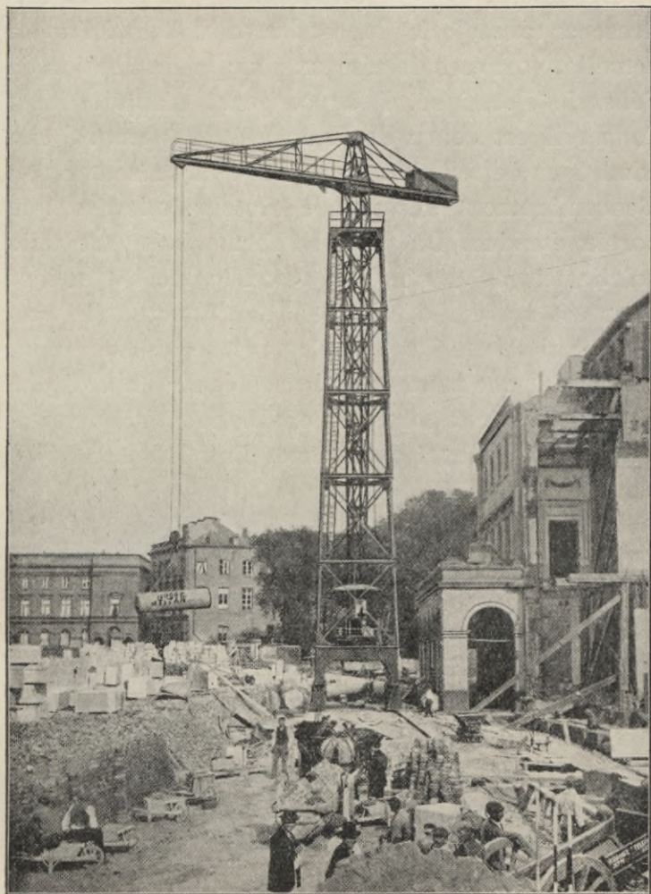
Grue à pilone.
