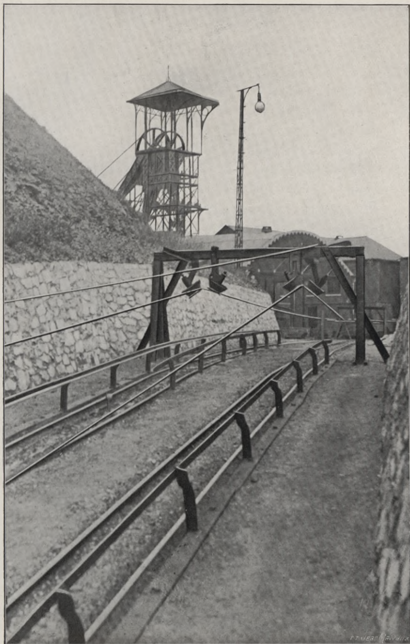
Trainage par câble flottant.
