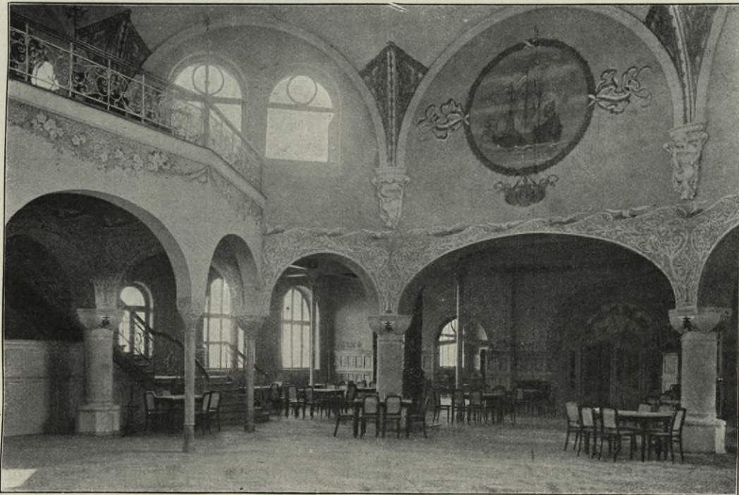
Wartesalon für Kajütsreisende im Empfangsgebäude der H. A. L.
