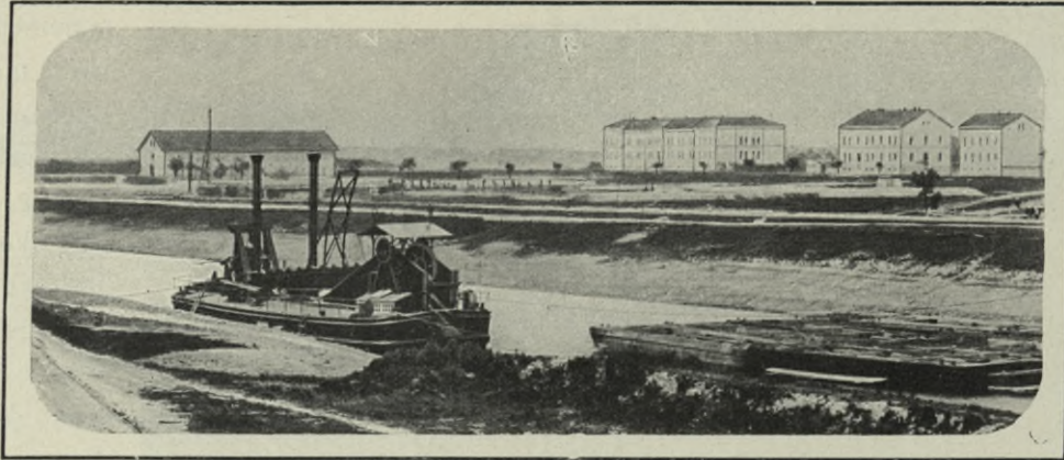
Alt-Wilhelmshaven: Herstellung des Hafenkanals zur Werft.
