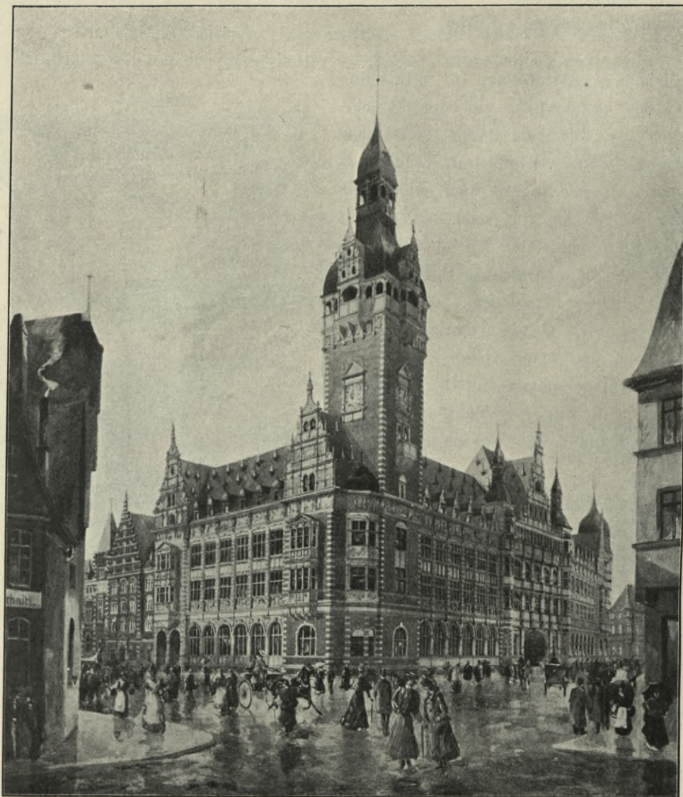
Im Bau befindliches Hauptverwaltungs-Gebäude des Norddeutschen Lloyd.
