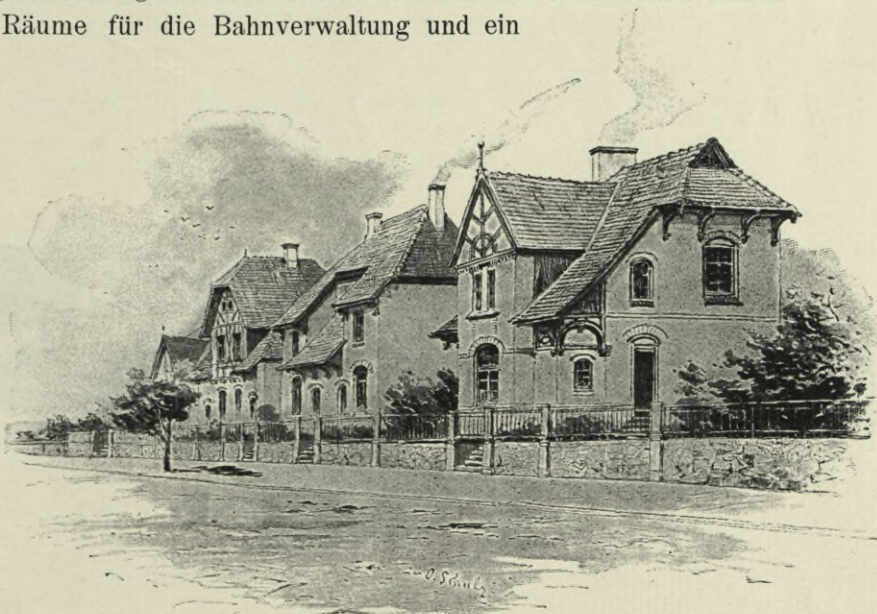
Arbeiterwohnungen in Cuxhaven.
