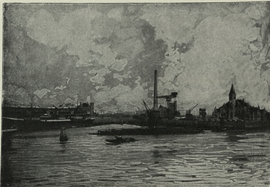
Blick auf die Speicher, die elektrische Zentrale und die Verwaltungsgebäude der Hamburg-Amerika Linie.
