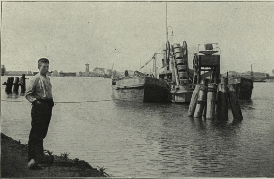
Baggerarbeiten im Kaiser Wilhelm-Kanal bei Brunsbüttel.
