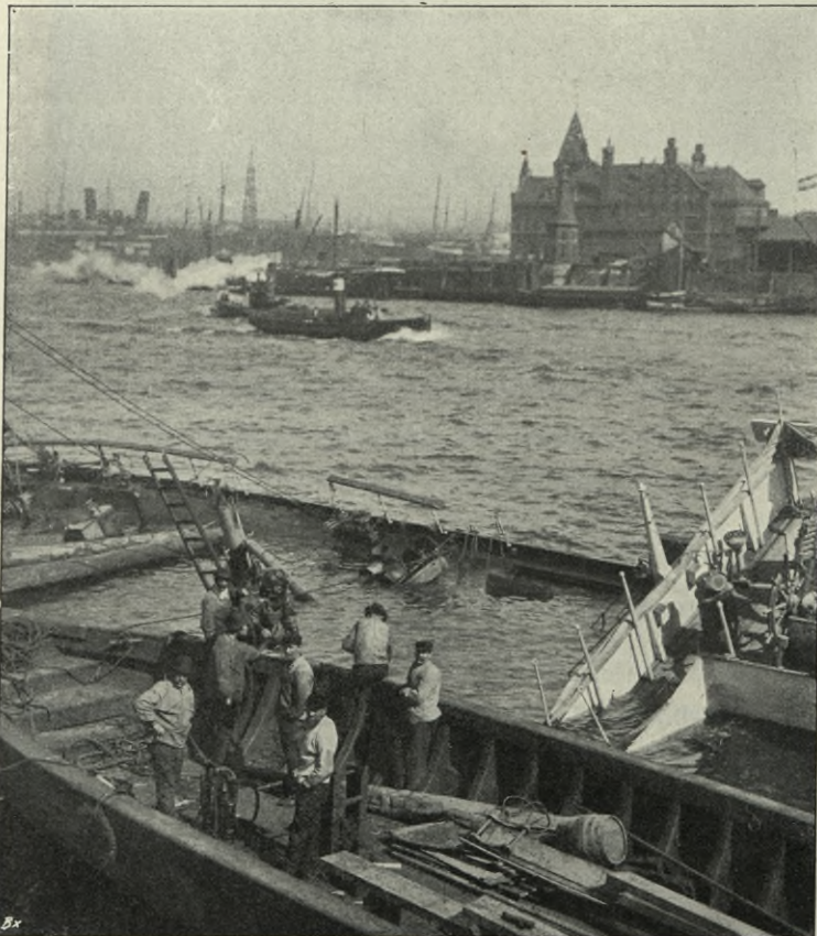
Hebung eines gesunkenen Dampfers im Hamburger Hafen.
