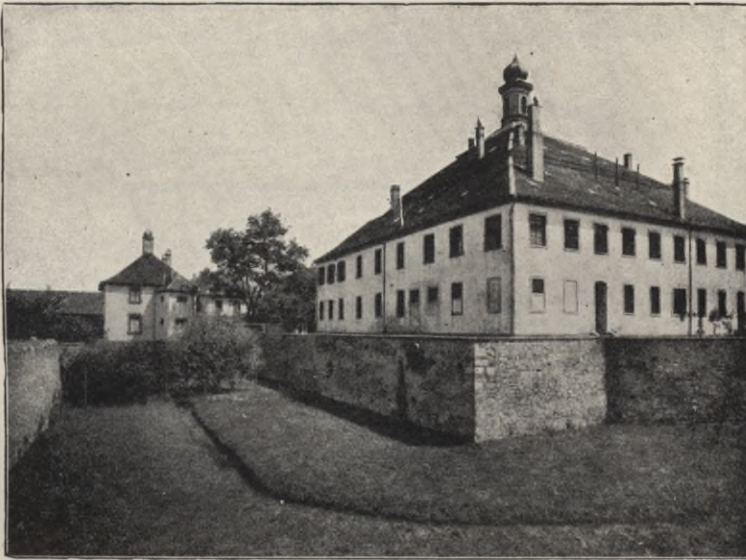
Fig. 90. Ansicht des Hauptschloßbaues zu Kißlau von Südwesten.
