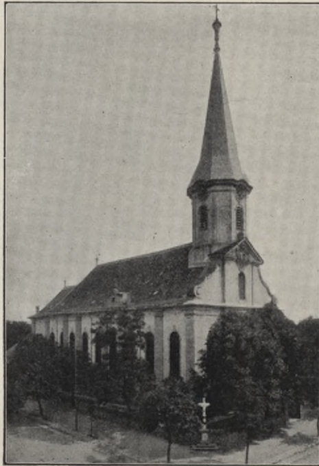
Fig. 85. Peterskirche zu Huttenheim.
