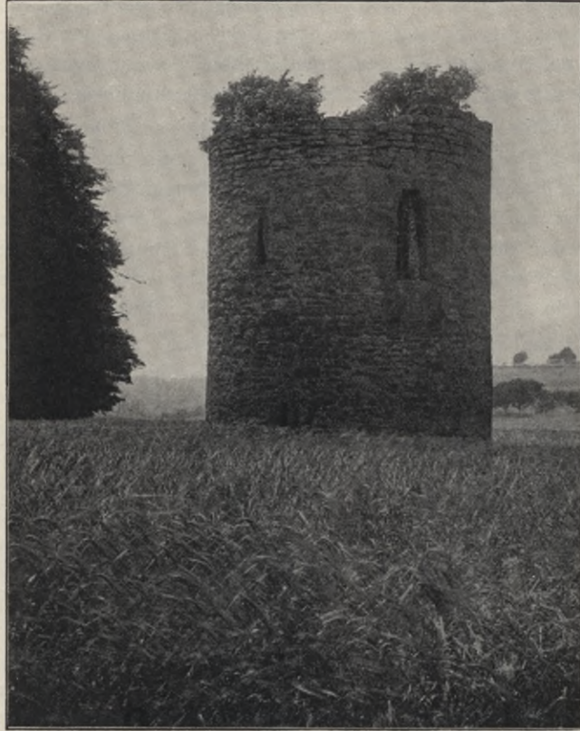
Fig. 120. Befestigungsturm im Südwesten des Odenheimer Klosters.
