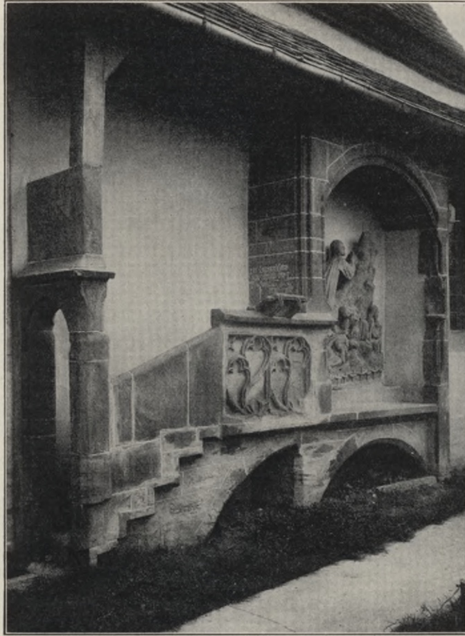
Fig. 117. Außenkanzel und Ölberg an der Mauritiuskirche zu Oberöwisheim.
