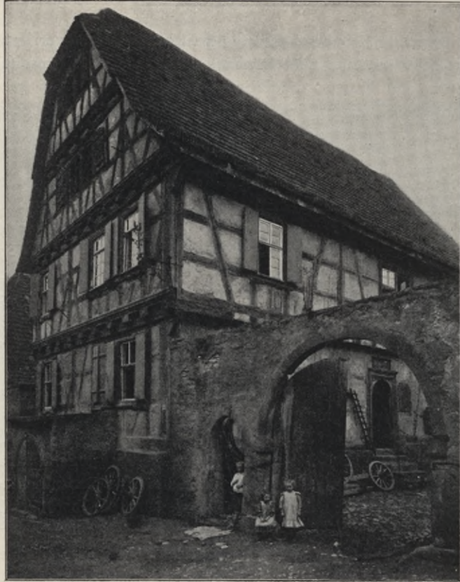
Fig. 83. Fachwerkhaus Nr. 371 in Heidelberg.
