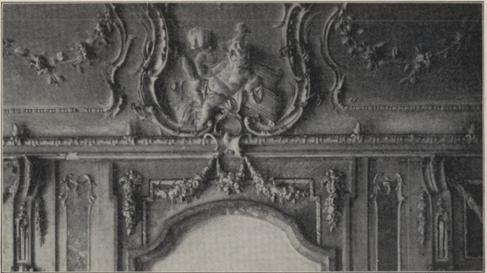
Fig. 97. Wand- und Deckenschmuck im Bad des Hauptschloßbaues zu Kießlau.
