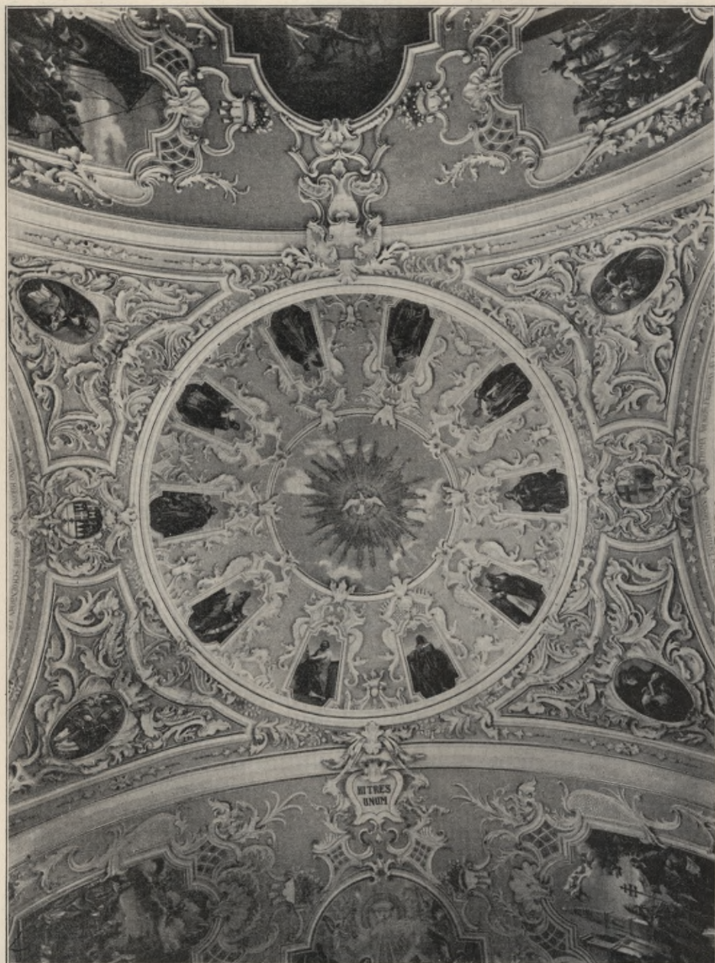
Fig. 14. Kuppel der Peterskirche zu Bruchsal mit Stukkatur.
