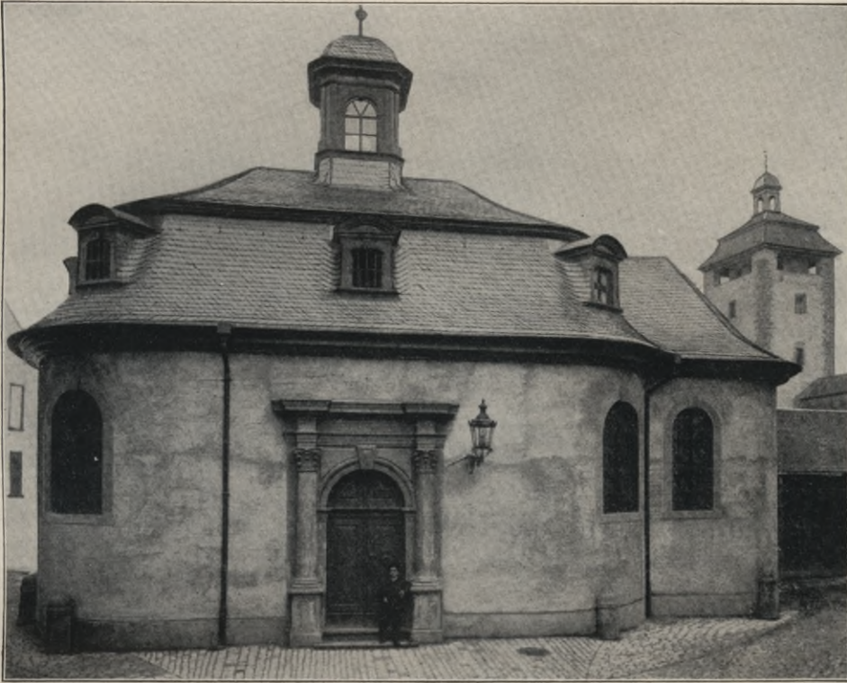
Fig. 21. Kapelle des alten Fürst-Stirum-Krankenhauses.
