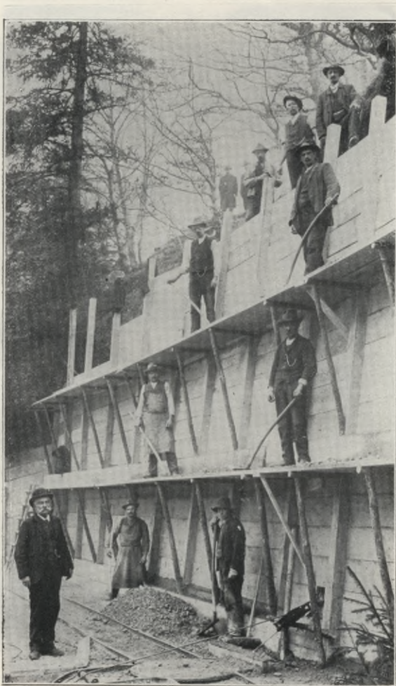
Abb. 19. Isarsteilhänge bei München. Einbringen des Betons.
