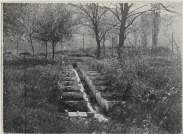
Abb. 31. Forellenzuchtanlage Nußloch. Terrassenförmige Betonbehälter.
