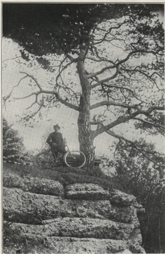
Abb. 17. Isarsteilhänge bei München. Nach der Sicherung durch Eisenbeton.
