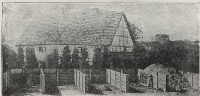
Abb. 38 b. Buchten für Erde etc. aus Eisenbeton.
