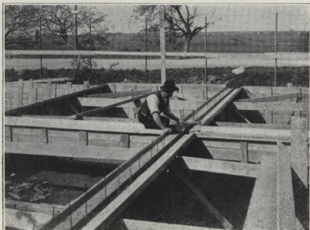
Abb. 29. Forellenzuchtanlage Nußloch. Verschalen der Rippen.
