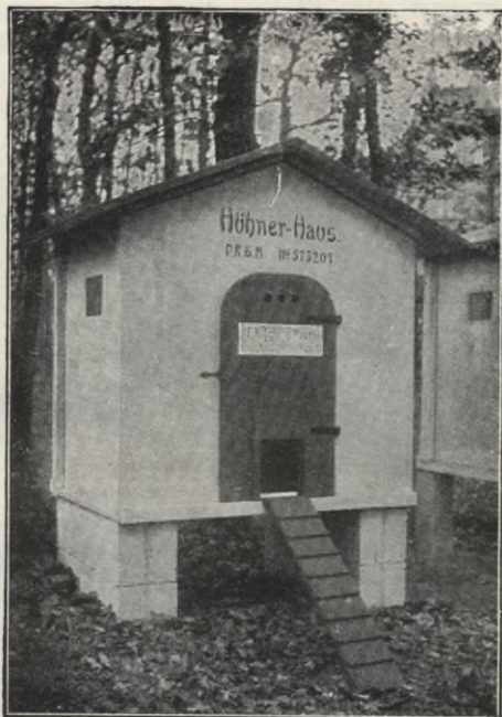
Abb. 42. Hühnerhaus aus Beton.
