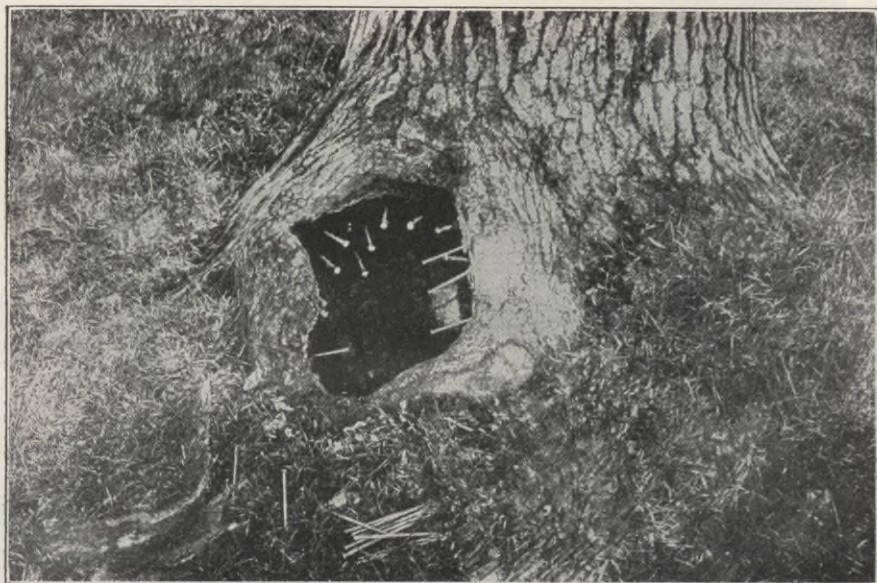
Abb. 35. Ausbetonierung eines hohlen Baumes.
