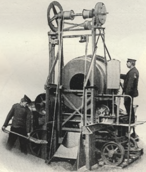
Abb. 51. Trommelmischer „Ransome“.
