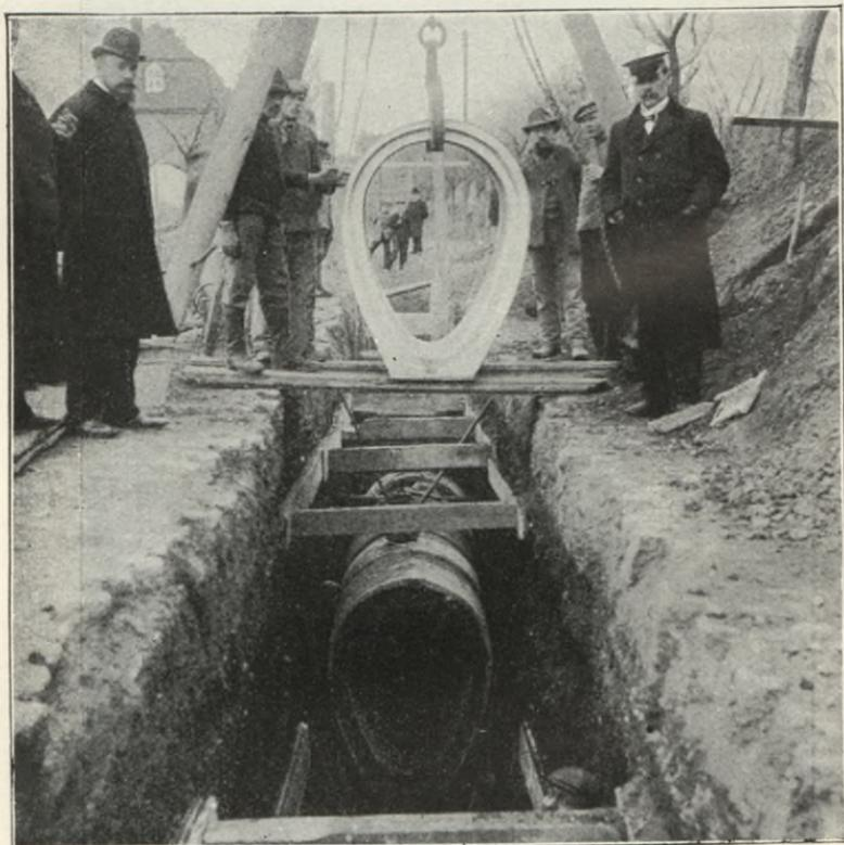
Abb. 35. Verlegen von Cementrohren.
