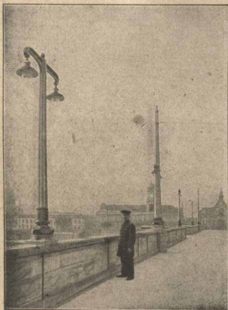
Abb. 30. Stahlbeton-Schleudermaste auf der neuen Friedrich-August-Brücke in Dresden. (Otto & Schlosser, Meißen.)
