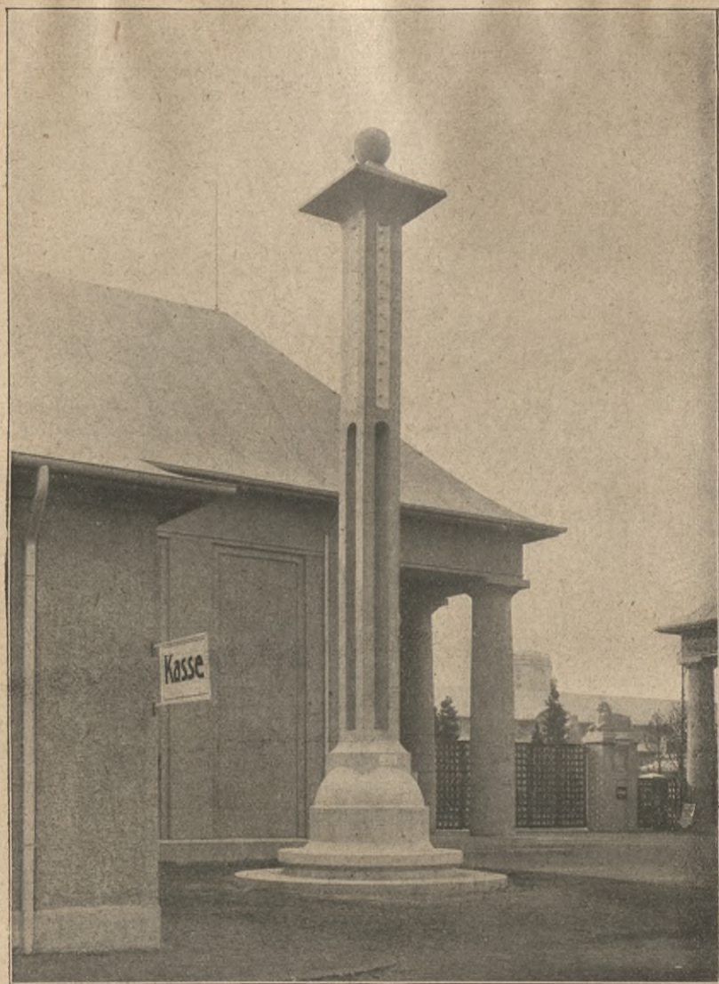
Abb. 38. Eisenbeton-Lichtmast am Haupteingang der Internationalen Baufach-Ausstellung Leipzig. (Rud. Wolle, Leipzig.)
