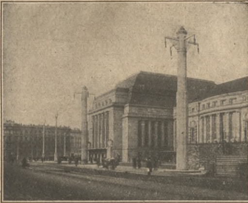
Abb. 23. Lichtmaste vor dem Leipziger Hauptbahnhof.
