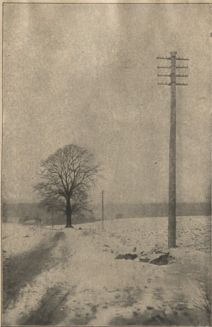
Abb. 34. Panzerbetonmaste in der Telephonlinie Cassel-Ochshausen. (E. Lange, Cassel.)
