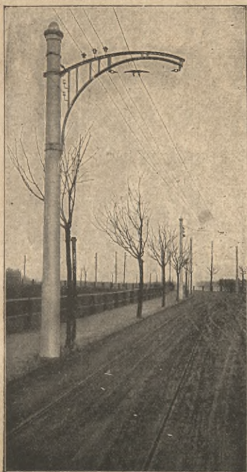
Abb. 29. Stahlbeton-Schleudermast in der Straßenbahnstrecke Dresden-Klotzsche.
