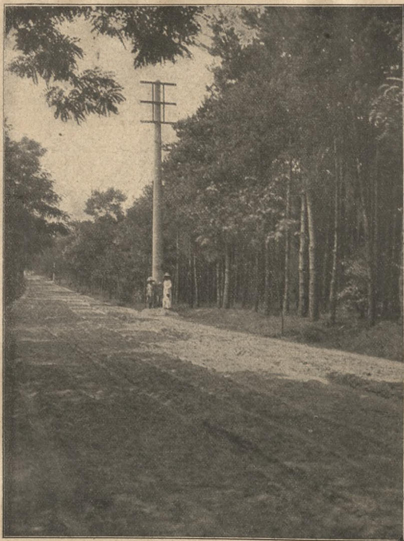
Abb. 31. Siegart-Leitungsmaste. (Ellmer & Co., Stettin.)
