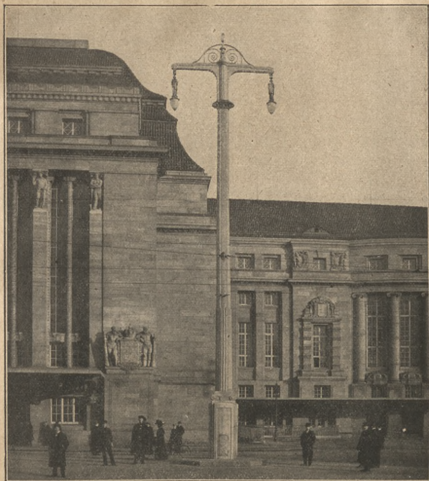
Abb. 37. Zweilampenträger vor dem Hauptbahnhof in Leipzig. (Rud. Wolle, Leipzig.)
