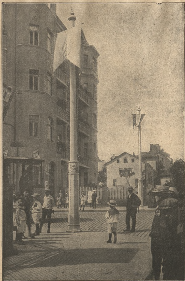
Abb. 33. Profiliertes Panzerbetonmast für Straßenbahnleitung. (E. Lange, Cassel.)
