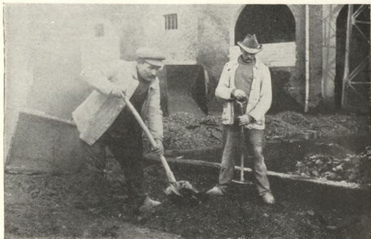
Herstellung eines Fußweges aus Beton. Abb. 18. Einbringen und Feststampfen der Schlackenschicht.
