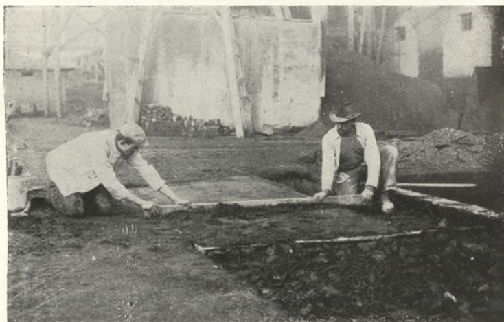
Herstellung eines Fußweges aus Beton. Abb. 19. Abziehen des Betons.
