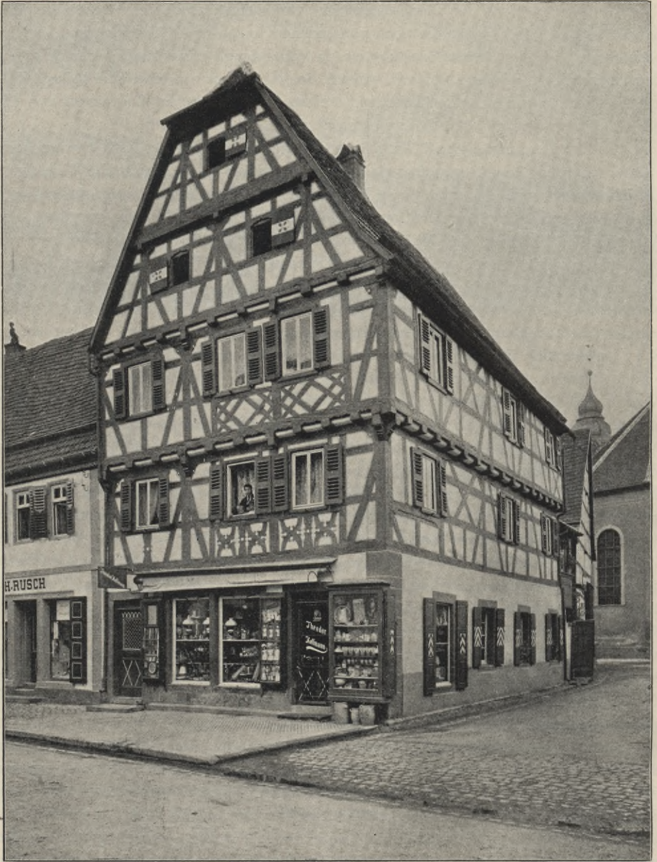
Fig. 52. Altes Fachwerkhaus in Sinsheim. (Restauriert.)
