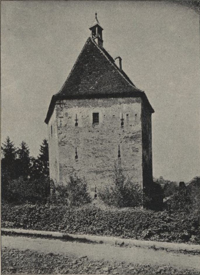
Fig. 13. Ansicht des fünfseitigen Turmes von der Außenseite her.
