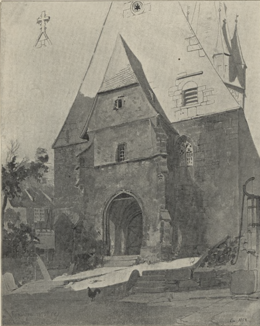
Fig. 73. Die katholische Pfarrkirche zu Eppingen. (Zustand vor der Restauration.)
