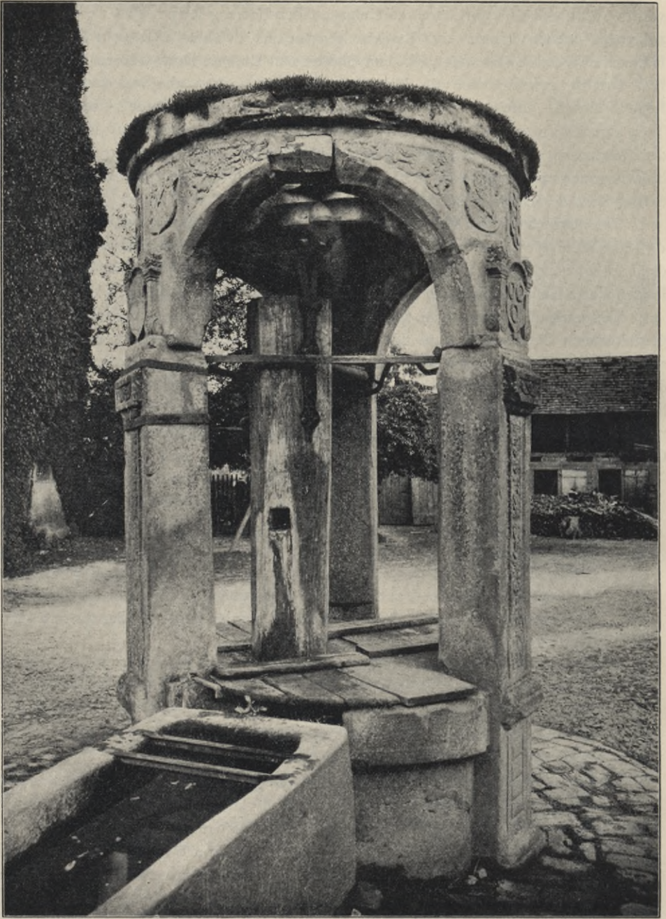
Fig. 10. Ziehbrunnen im Hofe des ehemaligen Wasserschlosses zu Helmstatt.
