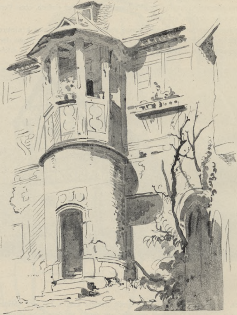
Fig. 36. Treppenturm in der Vorburg zu Neidenstein.
