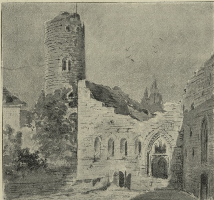
Fig. 14. Burg Krautheim. Ansicht der Ostseite. (Zustand i. J. 1888.)
