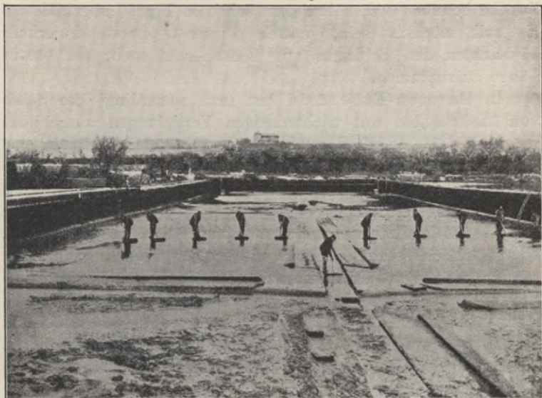
Fig. 61. Ausräumung von Schlamm aus Flachbecken, alte Methode Bolton.
