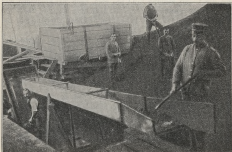
Fig. 89. Hamburger Verfahren zur Reinigung verschlammter Füllkörper.
