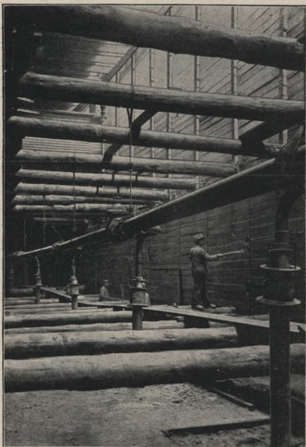
Abb. 62. Bau der Untergrundbahn Wittenbergplatz-Kaiserallee. Mehrstellige Grundwasserhaltungsanlage für die Herstellung zweier Tunnelstockwerke unter der Taentzienstraße in Charlottenburg; Tiefe der Absenkung 9,5 m.
