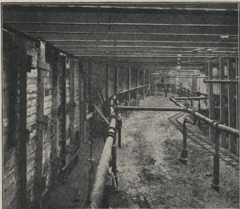
Abb. 54. Bau der Berlin-Schöneberger Untergrundbahn. Leitungsnetz der Wasserhaltung in der Tunnelbaugrube der Motzstraße in Berlin-Schöneberg. Ausgeführt durch Siemens & Halske, Akt.-Ges.
