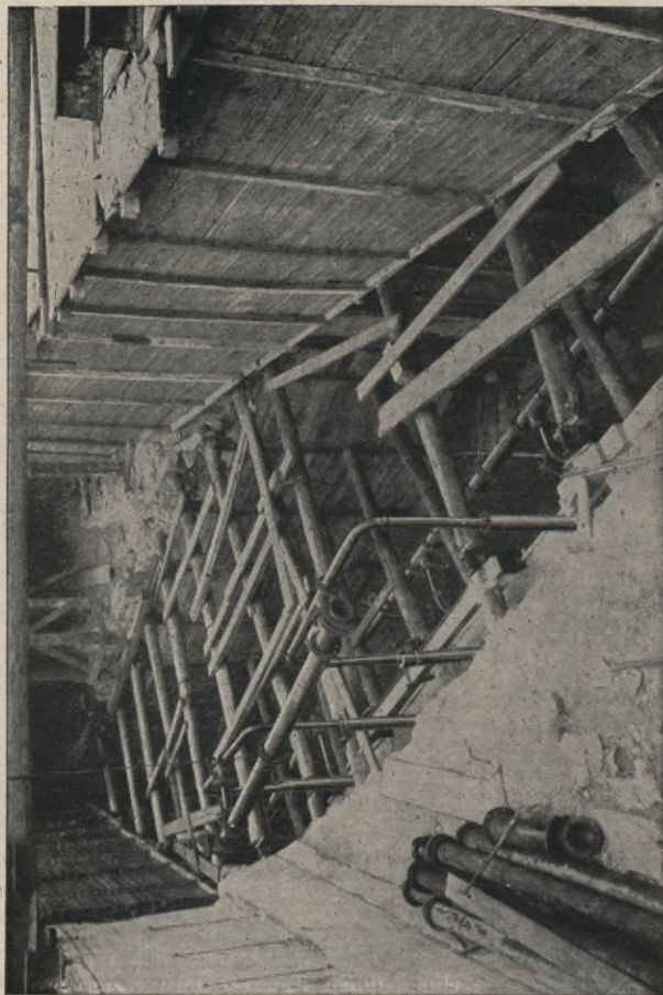
Abb. 59. Umbau der Haltestelle „Wittenbergplatz“. Verlegen der Leitungen für die Wasserhaltung im Tieftunnel an der Nettelbeckstraße.
