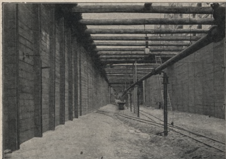
Abb. 10. Eingeschalte und abgesteifte Baugrubenwände eines Untergrundbahntunnels.
