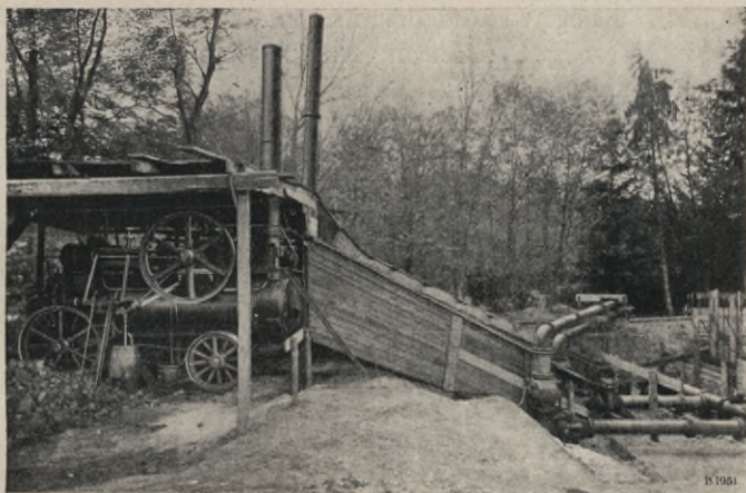
Abb. 34. Pumpenantrieb durch zwei Lanzsche Lokomobilen beim Bau der Entwässerungsanlage für ein Gewächshaus im Park zu Sanssouci (Potsdam).
