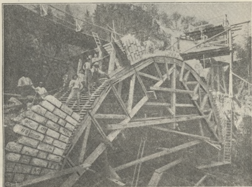
Abb. 98. Mursanger-Viadukt auf der Tauernbahn.
