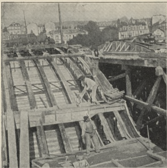
Abb. 157. Brücke Chauderon-Montbenon. Betonierung des Gewölbes.
