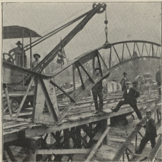
Abb. 156. Brücke Chauderon-Montbenon. Aufstellen der Eisenbogen.
