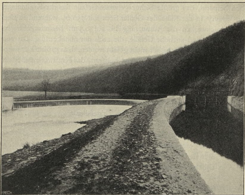
Abb. 5. Wehr in der Wupper mit Einlaßschleuse zum Betriebskanal für das Wasser- und Elektrizitätswerk der Stadt Solingen.
