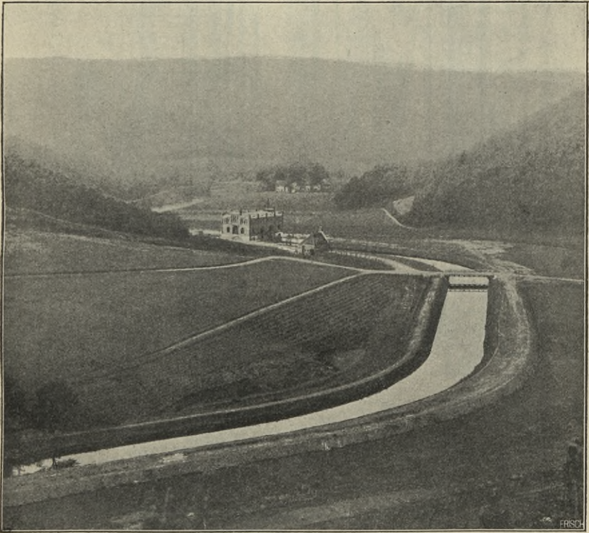
Abb. 7. Betriebskanal vom Wehr zum Kraftwerk der Stadt Solingen. Länge: 1170 m. Sohlenbreite: 8 m. Sohlengefälle: 1:1000. Wasserführung i. M.: 12 cbm/sek.
