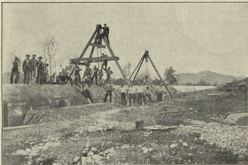
Abb. 19. Rohr von 3,3 m Durchmesser aus genietetem Stahlblech für die Druckleitung der Kraftanlage von Champ (Isère).
