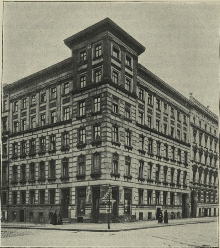
Abb 44. 6 und 7stöckige Mietkasernen. Zionskirchstraße
