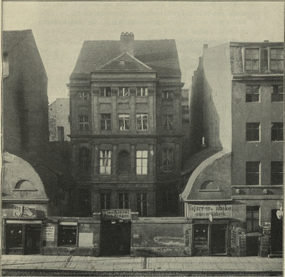
Abb. 24. Wallstr. 72 (abgerissen) Nach einer Photographie von F. Albert Schwartz, Berlin NW 87
