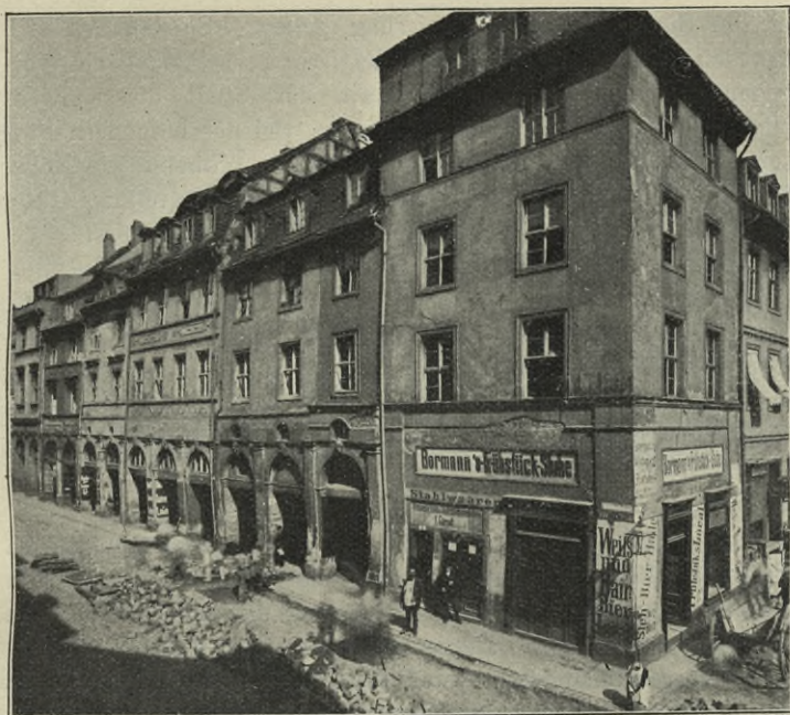
Abb. 26. Ecke Mühlendamm und Fischerstrasse (abgerissen). Nach einer Photographie von F. Albert Schwartz, Berlin NW 87
