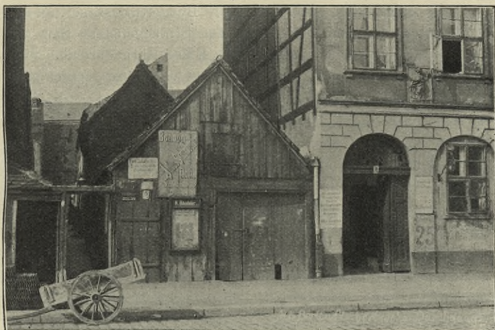
Abb. 21. Eingang von der Fischerbrücke zum Durchgang nach der Fischerstraße Nach einer Photographie von Arpád Johann Schuh, Berlin C 2
