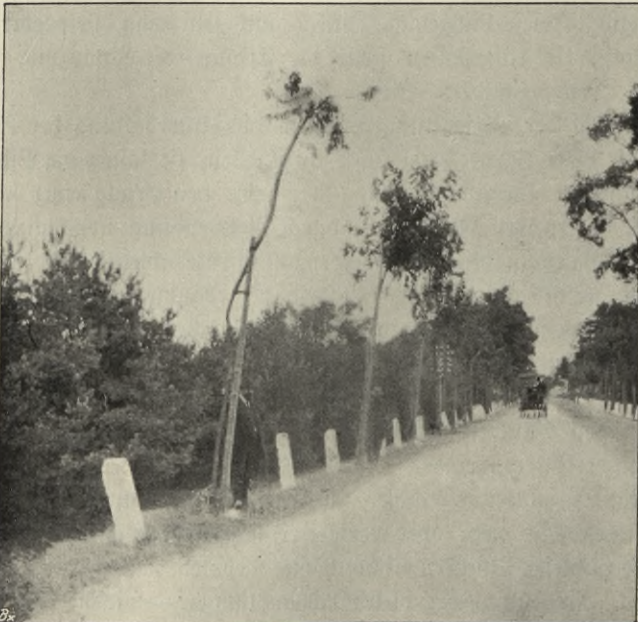
Abb. 2. Schlechte und vernachlässigte Baumpflanzung. Die zu hoch aufgestützten Stämme sind so schwach, daß sie die schlecht entwickelten Kronen nicht zu tragen vermögen.
