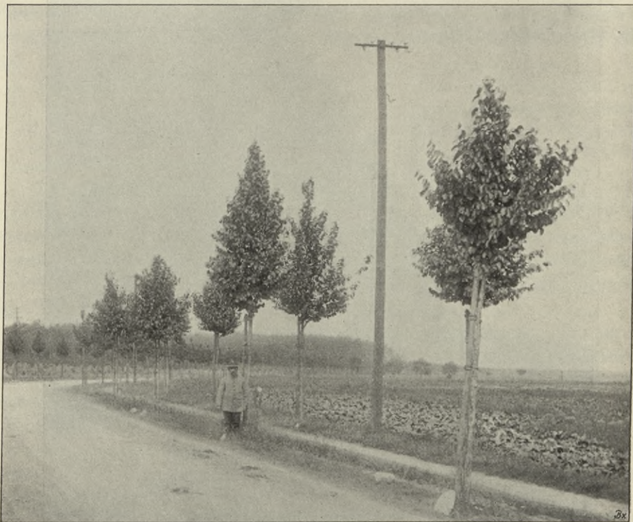
Abb. 57. Aufstellung des Telegraphen gestänges in ausreichender Länge auf der äußeren Straßengrenze (im Schutzstreifen), die Bäume können sich ungehindert entwickeln.
