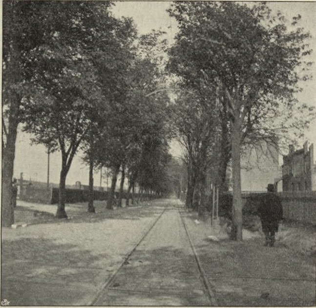
Abb. 54. Tunnelartiges Ausschneiden der Zweige und Äste einer älteren Baumpflanzung bei nachträglichem Einbau der Straßenbahn. Die hindernden Zweige und Äste sind — um Stummel zu verhüten — an ihren Ansatzstellen, d. h. auf Ast-ring abgeschnitten worden. Die Wirkung der Allee wurde — trotz des einseitig starken Eingriffs — hierdurch wenig beeinträchtigt.
