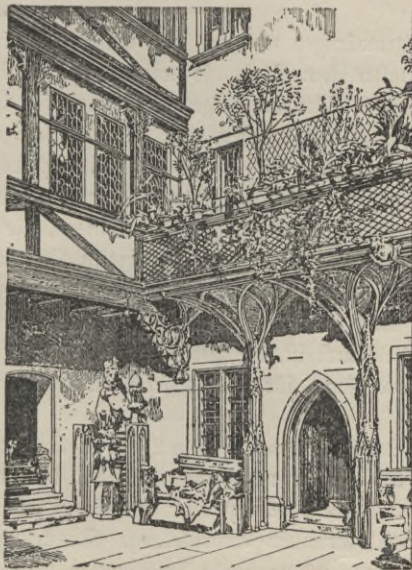
Fig. 136. Hofansicht aus Straßburg.
