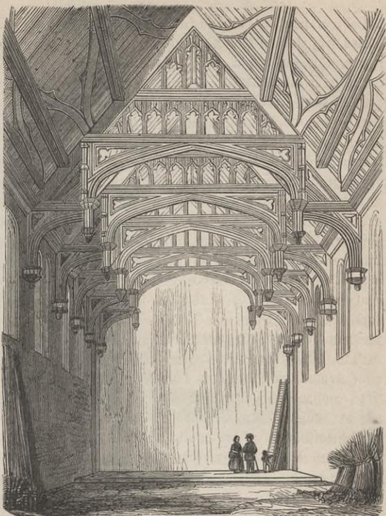
Fig. 354. Stichbalkendach mit Kehlbalken und Hängewerk aus dem Palast zu Ettham (um 1400).
