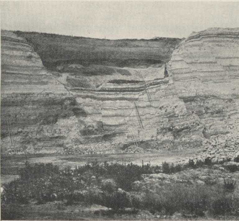
Fig. 30. Steinbruch der Dyckerhoff'schen Zementfabrik am Hessler bei Wiesbaden.
