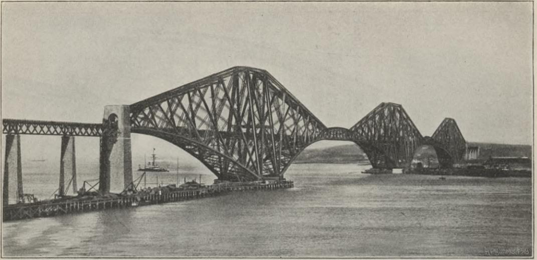
lichen Träger, leiden aber nicht unter deren Nachteilen, da eine Veränderung in der Höhenlage der Stützpunkte die Inanspruchnahme nicht beeinflusst. Für große und sehr große Stützweiten ist diese Brückenart überaus geeignet, insbesondere auch weil die Aufstellung des Überbaues ohne feste Gerüste von den Pfeilern aus möglich ist.
