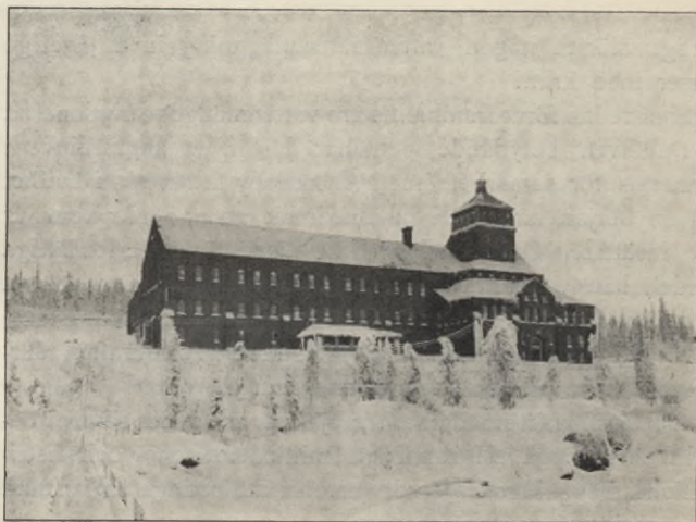
Fig. 25. Exteriör af ställverkshuset i Porjus. (Exterieur des Schaltgebäudes in Porjus.)
