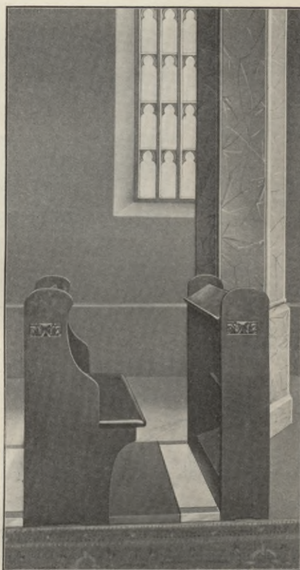
Fig. 10. »Radiophor»-plattor för uppvärmning af kyrkor. (»Radiophor»-Platten für Kirchenheizung.)
