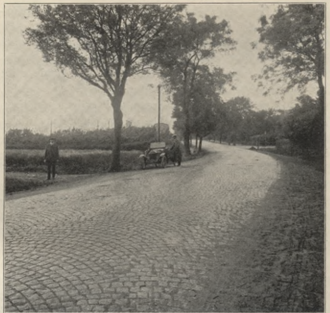
Fig. 4. Chaussebrolægning, 9.5 km fra Kjøbenhavn, 1 Aar gammel.
