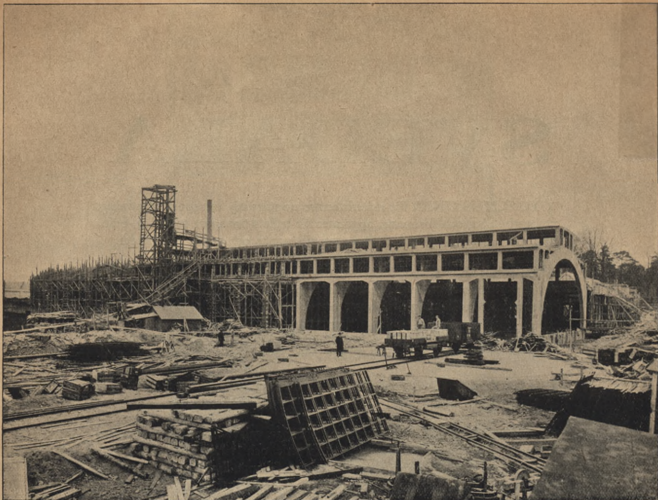
Statens Järnvägars nya lokomotivstallar vid Frösunda.
