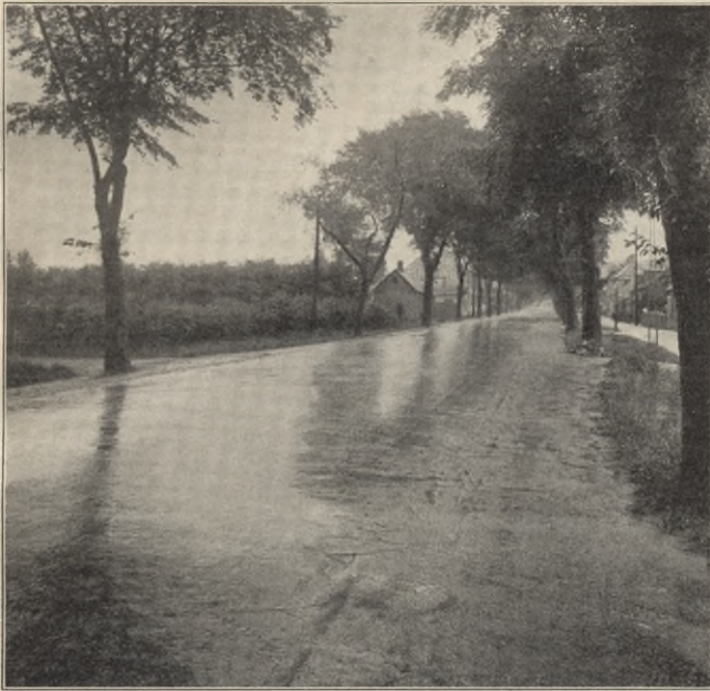
Fig. 2. Asfaltmakadam, 3,75 km fra Kjøbenhavn, 1 Aar gammel (efter Regn.)
