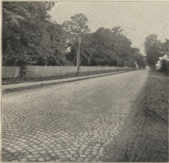
Fig. 3. Chaussebrolægning, 4.5 km fra Kjøbenhavn, 7 Aar gammel.
