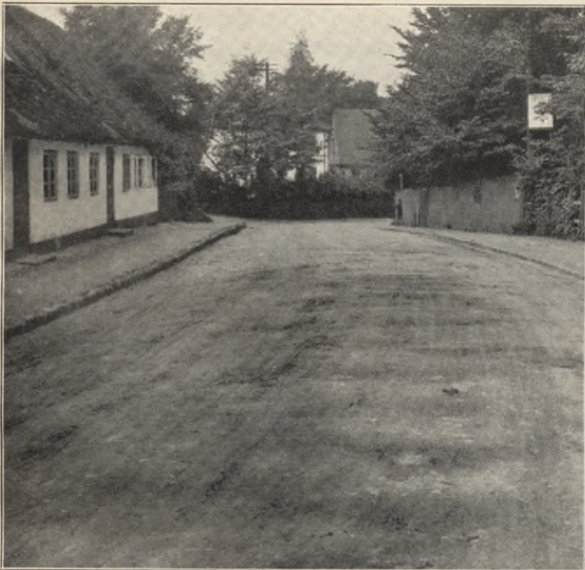
Fig. 1. God damptromlede Makadam, af Automobilfærdslen ødelagt.
