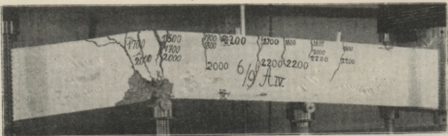
Abb. 58. Schaubild des gebrochenen Balkens Nr. 8 (Zement A, Bewehrung 1·03 v. H.).
