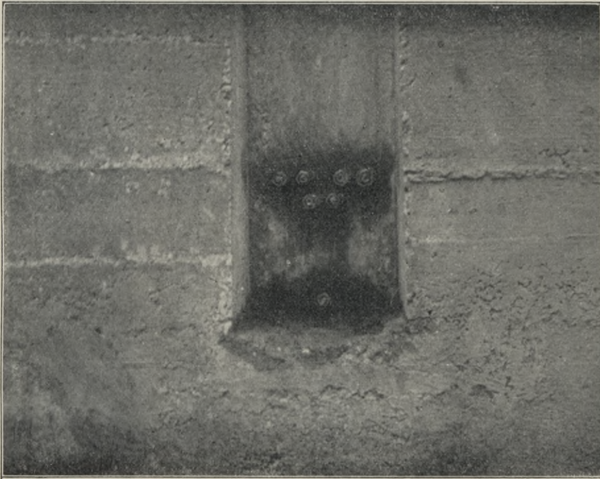
Abb. 124. Balkenstirn mit Schrauben in der Nische.
