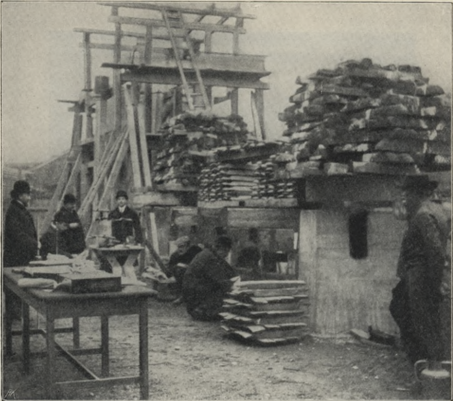
Abb. 24. Schaubild eines Versuches mit Widerlagerbelastung.
