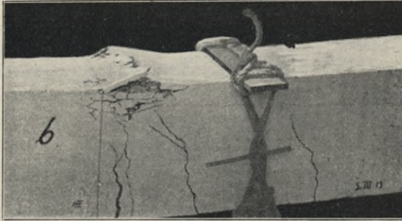
Abb. 167. Bruchbild des Balkens b .
