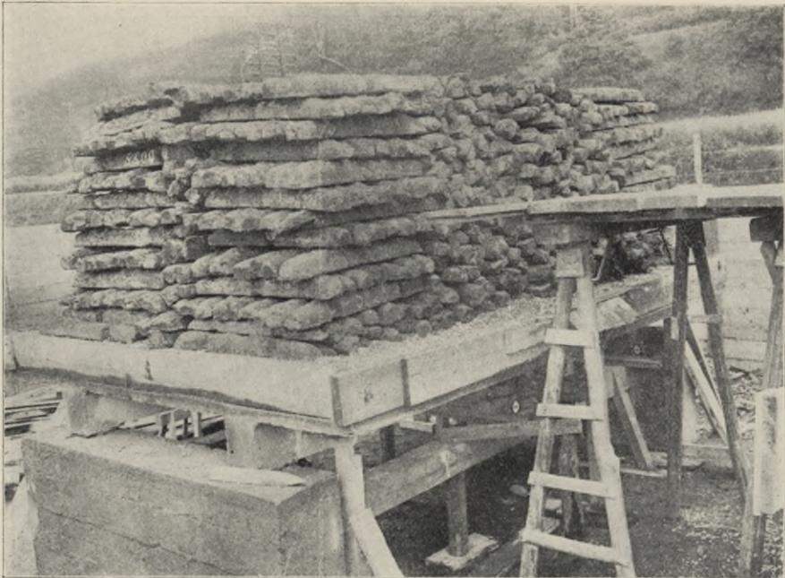
Abb. 19. Objekt 7a mit 35 t belastet.
