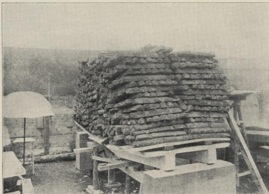
Abb. 15. Objekt 4b mit 54,7 t belastet.
