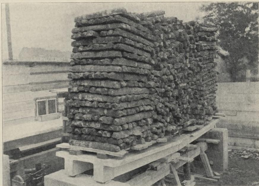
Abb. 14. Objekt 2b mit 36,3 t belastet.
