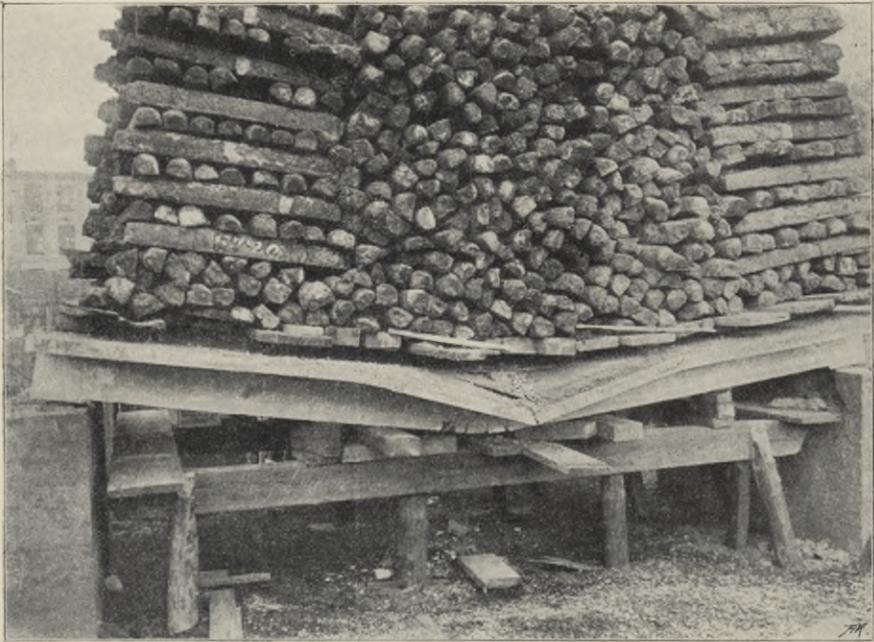
Abb. 18. Objekt 7b mit 68·2 t belastet.
