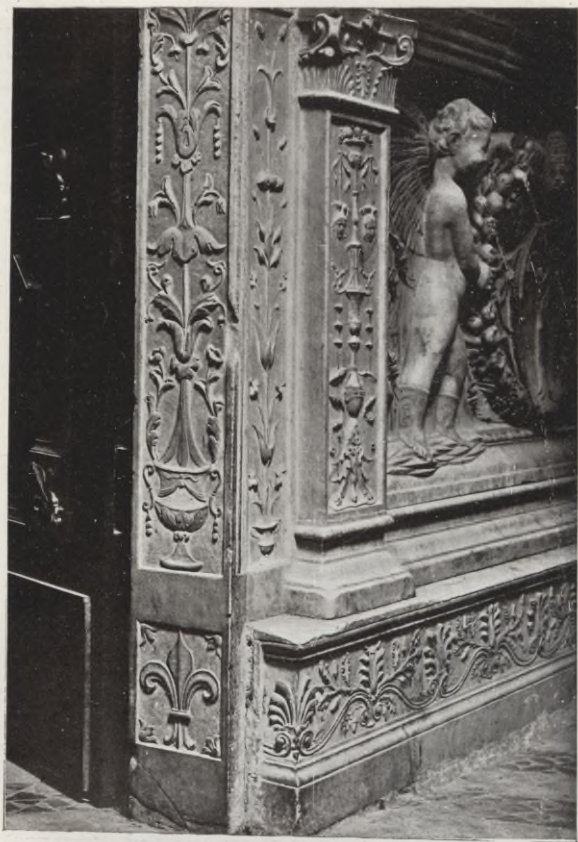
Cappella Sistina : Particolare della balaustrata. Chapelle Sixtine : Détail de la balustrade
