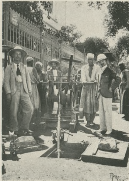
Einziehen eines Telephonkabels.
