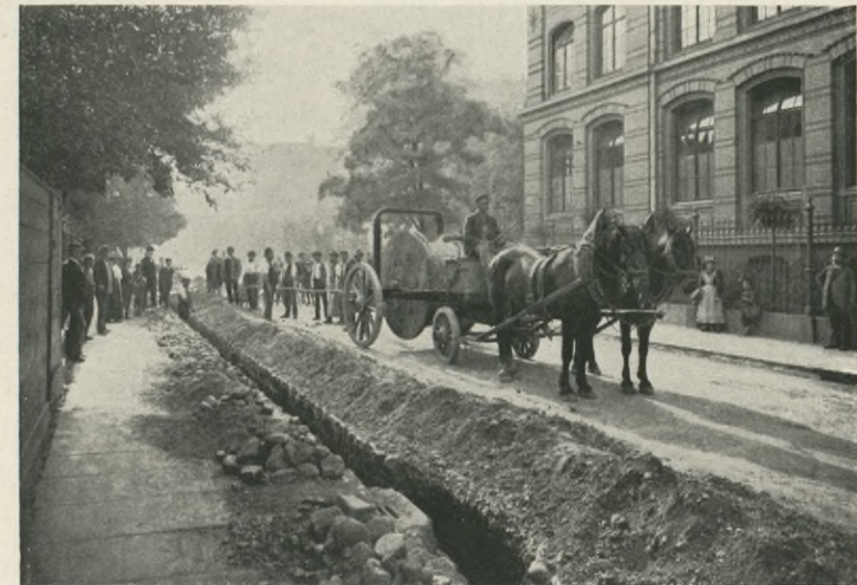
Einlegung eines Kabels in den Kabelgraben.
