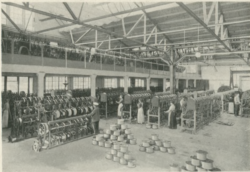
Isolierung von Telephondrähten mit Papier.
