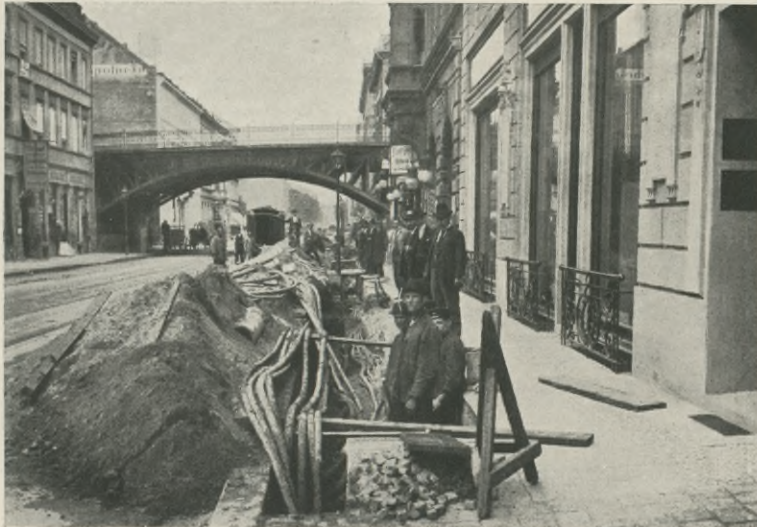
Verlegung von Kabeln im Erdreich
