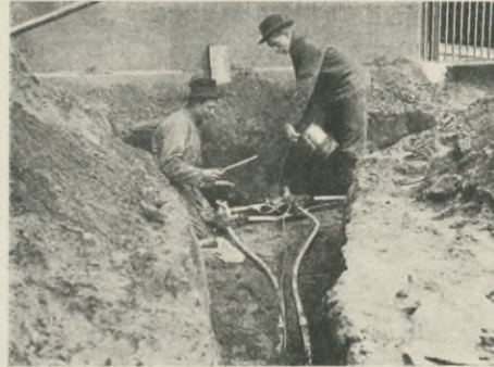
Herstellung einer Muffe.
