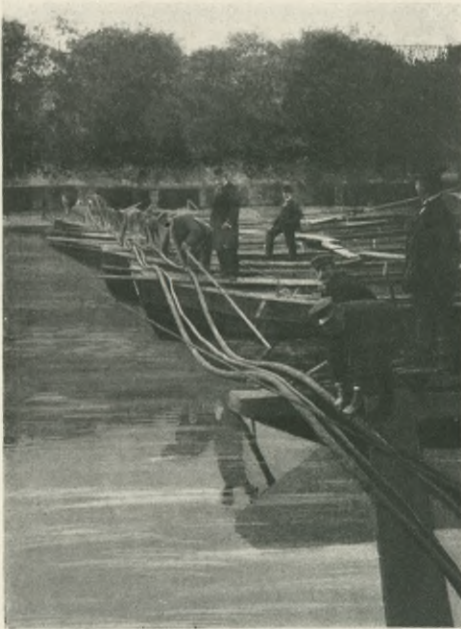
Verlegung eines Flufskabels.
