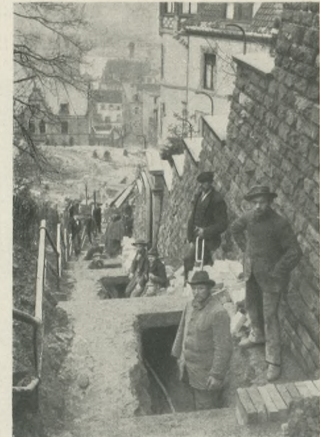
Kabelverlegung in Heidelberg.
