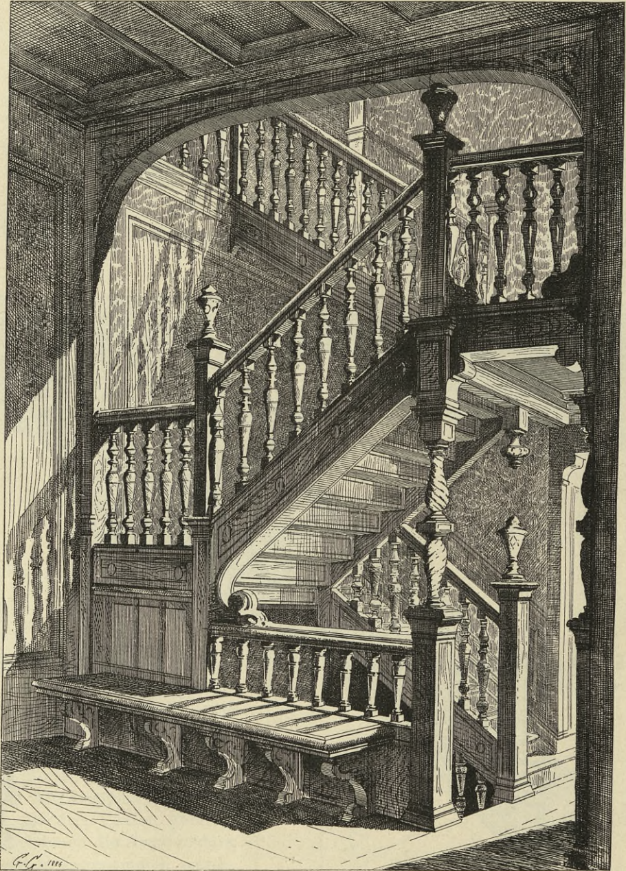
Treppe im Altersverforgungshaus zu Villemomble 20) .
