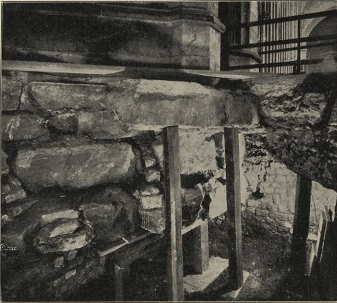
Abb. 10. Konsolartige Übermauerung der Fundamente.
