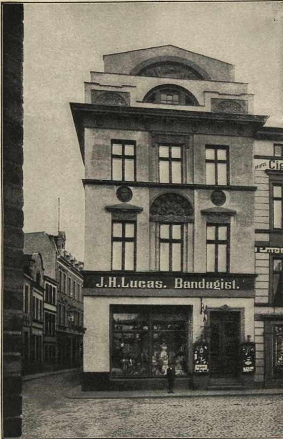
Abb. 21. Putzbau, durch Ladeneinbau entsteht.
