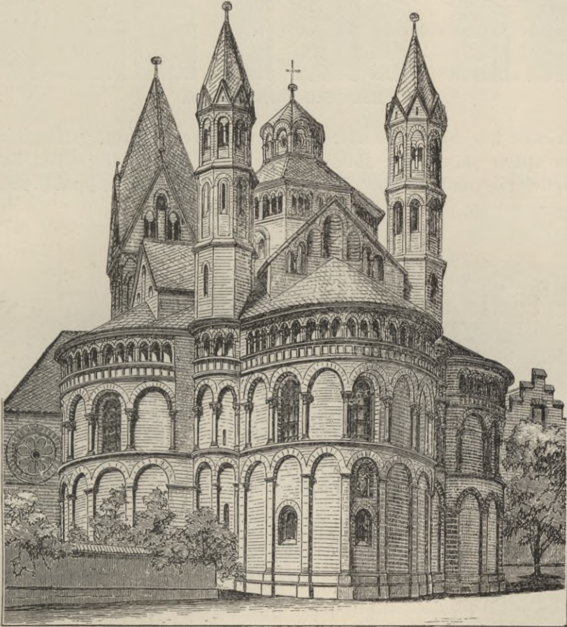
Apostelkirche zu Köln (nach Lübke).
