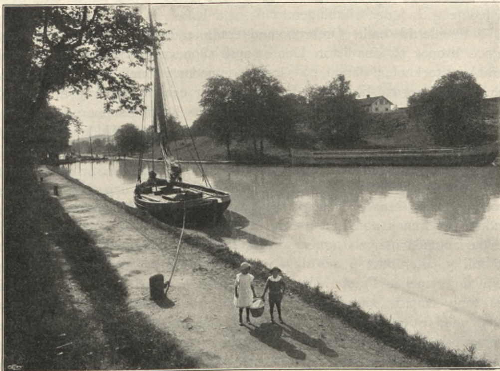
Fig. 24. Slussleden vid Brinkebergskulle före ombyggnaden.
