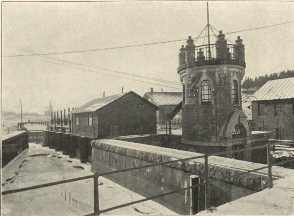
Fig. 11. Kraftstationen å östra Malgön. Uppströmssidan.
