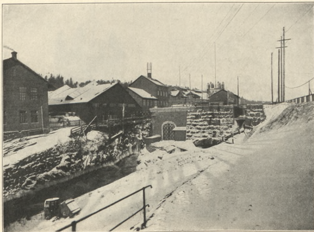
Fig. 12. Kraftstationen å östra Malgön. Nedströmsidan.
